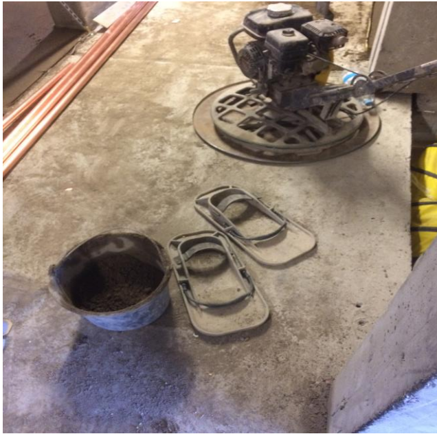
KUVA 11. Pinnan hiertämiseen tarkoitettu hierrin ja kenkiin kiinnitettävät alustat, jotka mahdollistavat aikaisemman pääsyn maakostean päälle.
