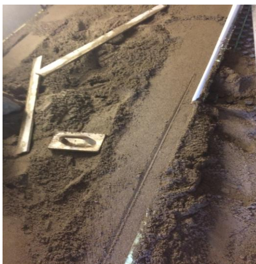
KUVA 9. Märkätilan erotus ja väliseinän alle jäävän kaistan tasoitus suoraksi
