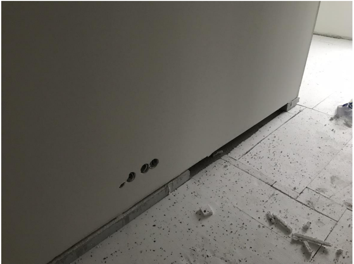
KUVA 18. Märkätilan kohdalla seinien alle jäävä rako täytettiin EPS-eristeellä
