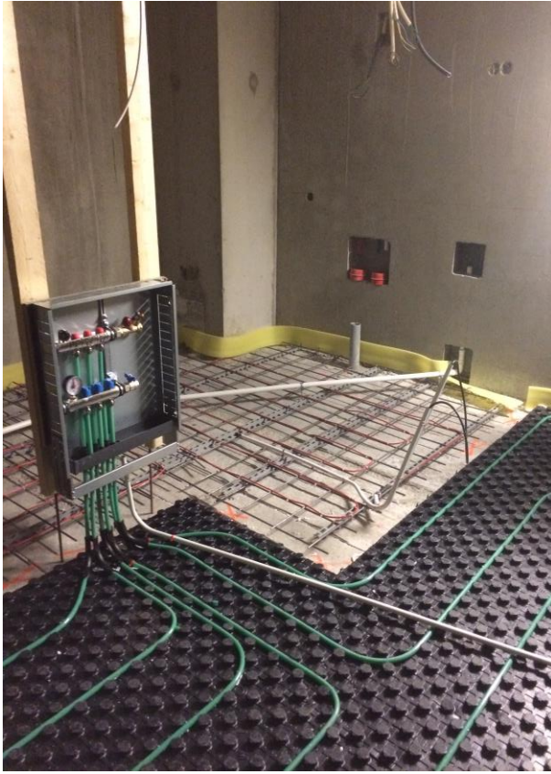
KUVA 7. Vesikiertoinen lattialämmitysputkisto koeponnistettiin ja sähkökaapelien toimivuus mitattiin ennen valua
