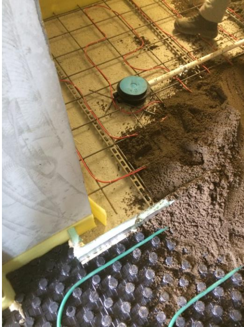
KUVA 8. Märkätila erotettuna huonetiloista
