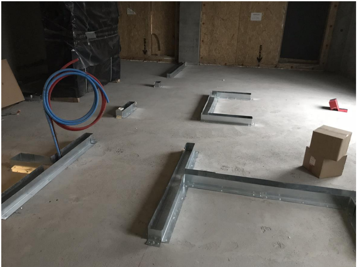
KUVA 17. Kevyen väliseinän alle tulevaa muottia valmiina
