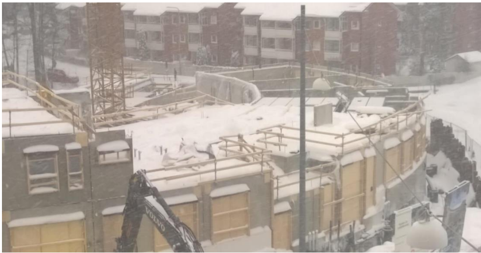
Kuva 2. Pakkanen ja lumi vaikeuttavat talvella rakentamista.
