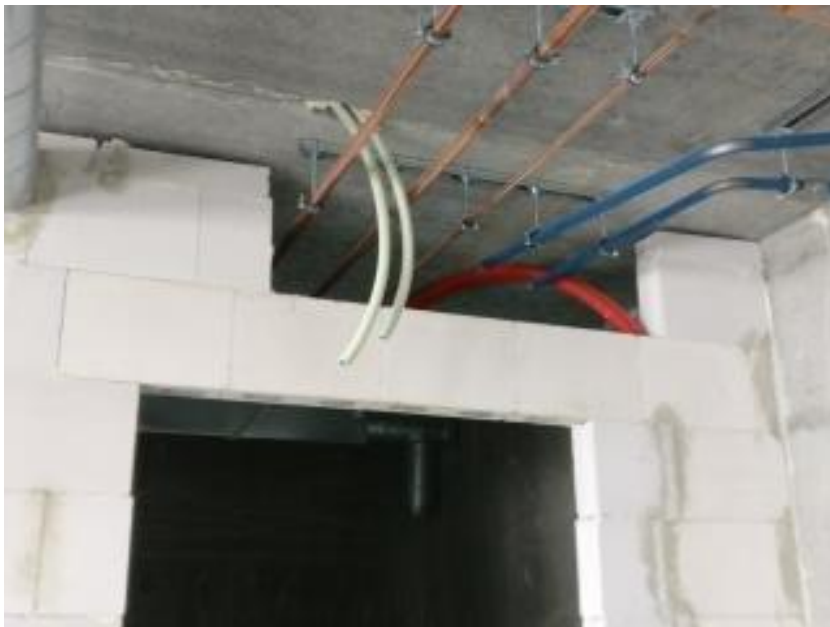
Kuva 8. LVI-putkivaraus
