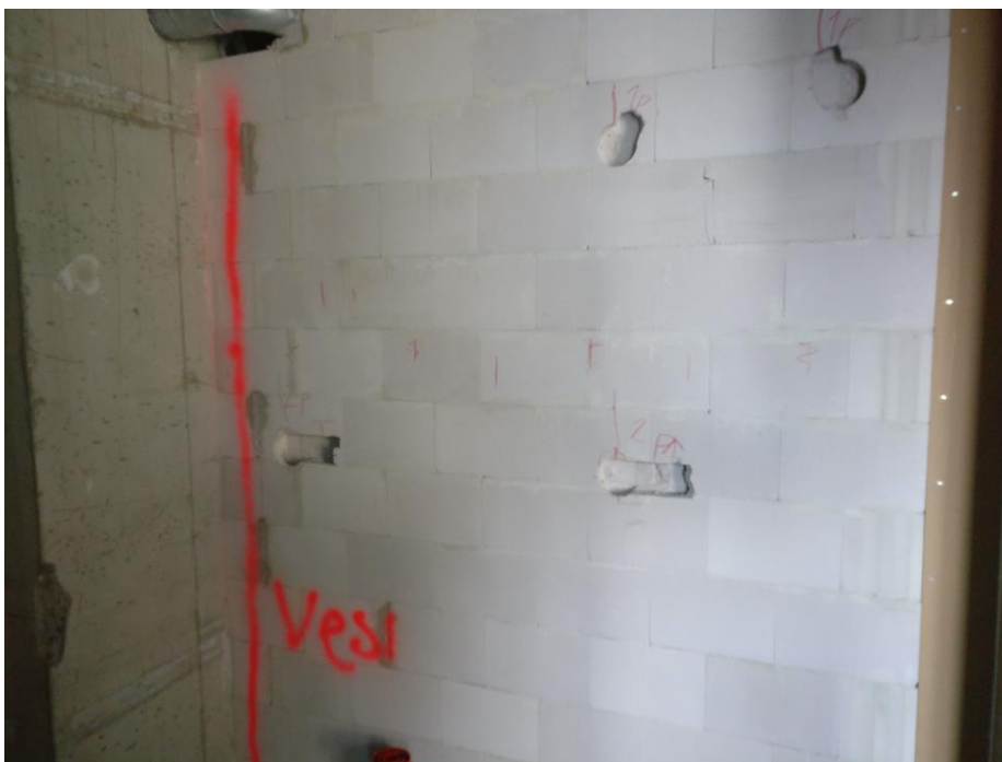
Kuva 11. Keittiön vesijohdot roilotaan seinään
