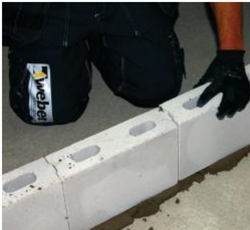
Kuva 3. Ensimmäisen harkkokerroksen muuraus [3.]
