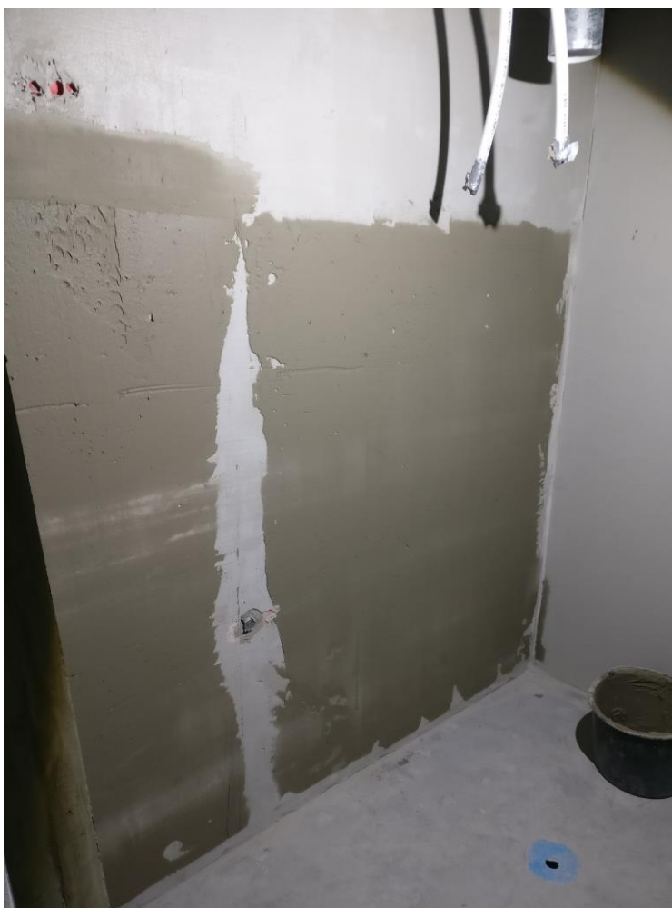
Kuva 12. Kahi-harkkoseinän oikaisu rappauslaastilla
