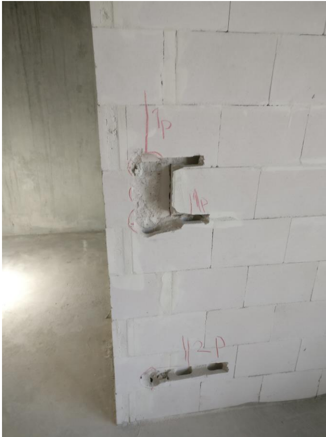
Kuva 9. Rasiavarauksia seinässä
