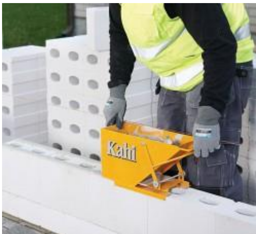
Kuva 4. Ohutsaumamuurausta laastikelkkaa käyttäen [3.]
