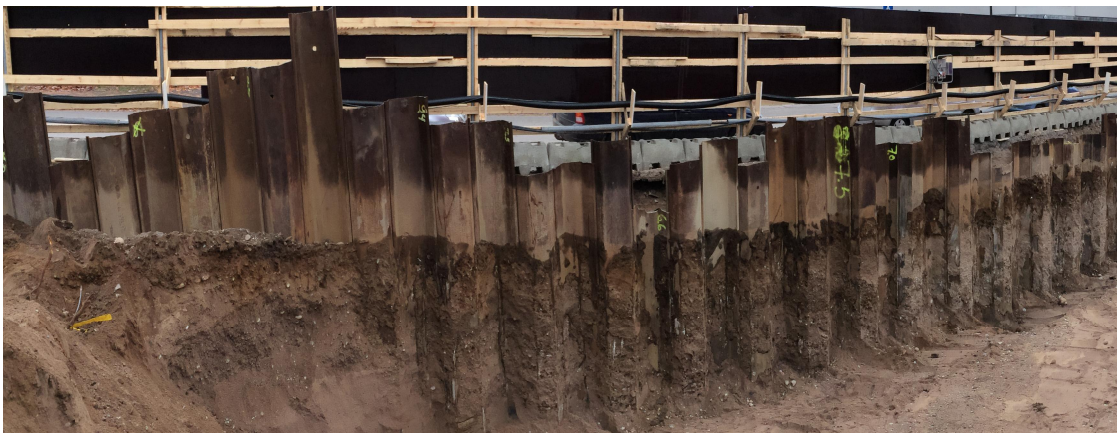
Kuva 5. Teräsponttiseinää U-profiilin ponteilla (Veli-Pekka Kaikkonen 2017)
