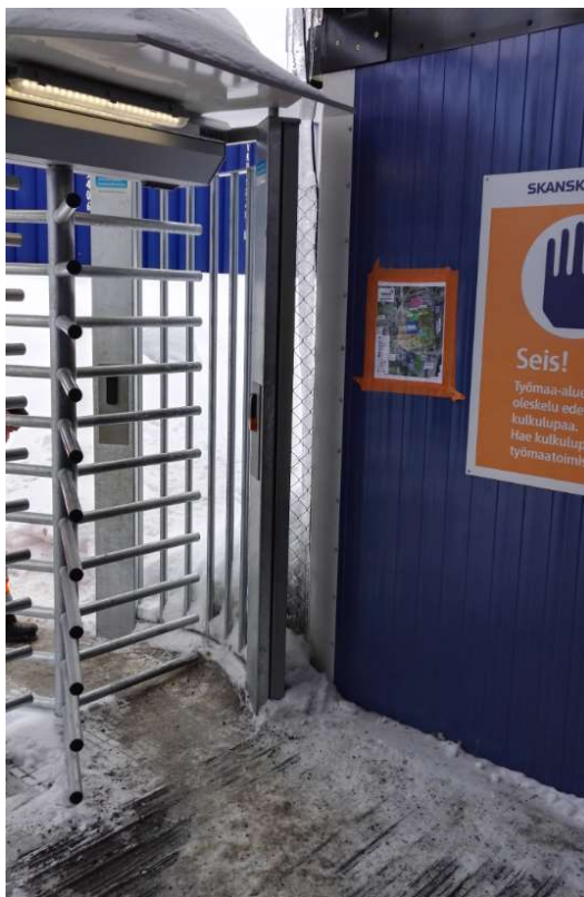
Kuva 8. Ulkoalueiden pelastussuunnitelma työmaaportin viereen sijoitettuna. (Kajaanin sairaalan työmaalta 2018.)
