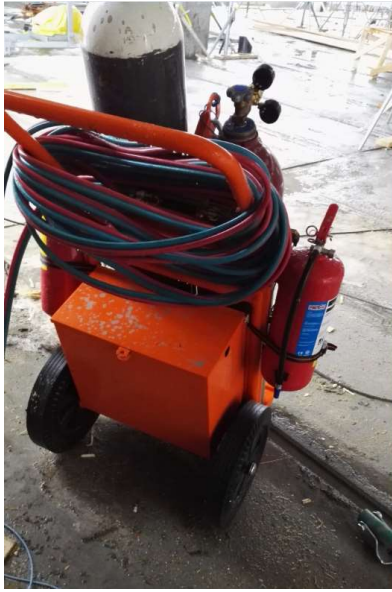
Kuva 34. Hitsauskärryyn tukevasti kiinnitetyt käsisammuttimet. (Kajaanin sairaalan työmaalla 2018.)
