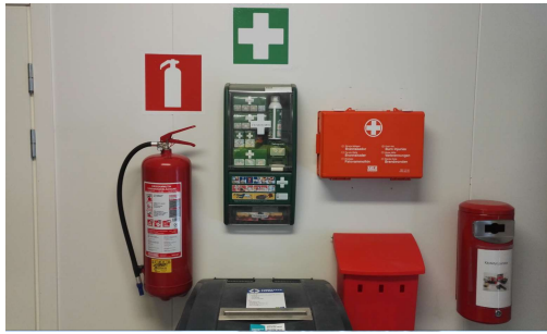
Kuva 7. Työmaatoimistossa sijaitsevat sammutin, ensiapu- ja palovammakaappi tarvittavin opastein. (Kajaanin sairaalan työmaalla 2012.)
