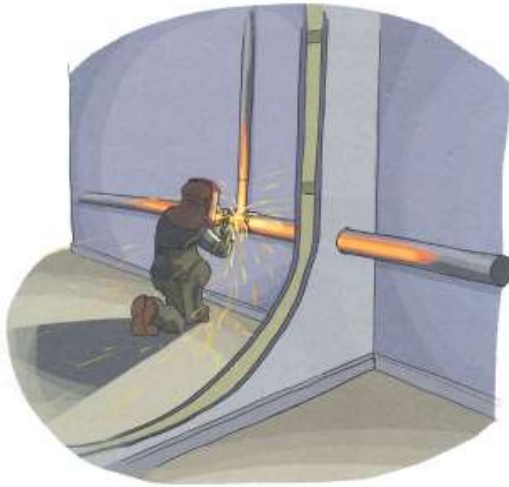
Kuva 25. Tulitöiden aikana lämpö voi siirtyä myös johtumalla työstettäviä putkia tai palkkeja pitkin. (Lindh 2015, 11.)
