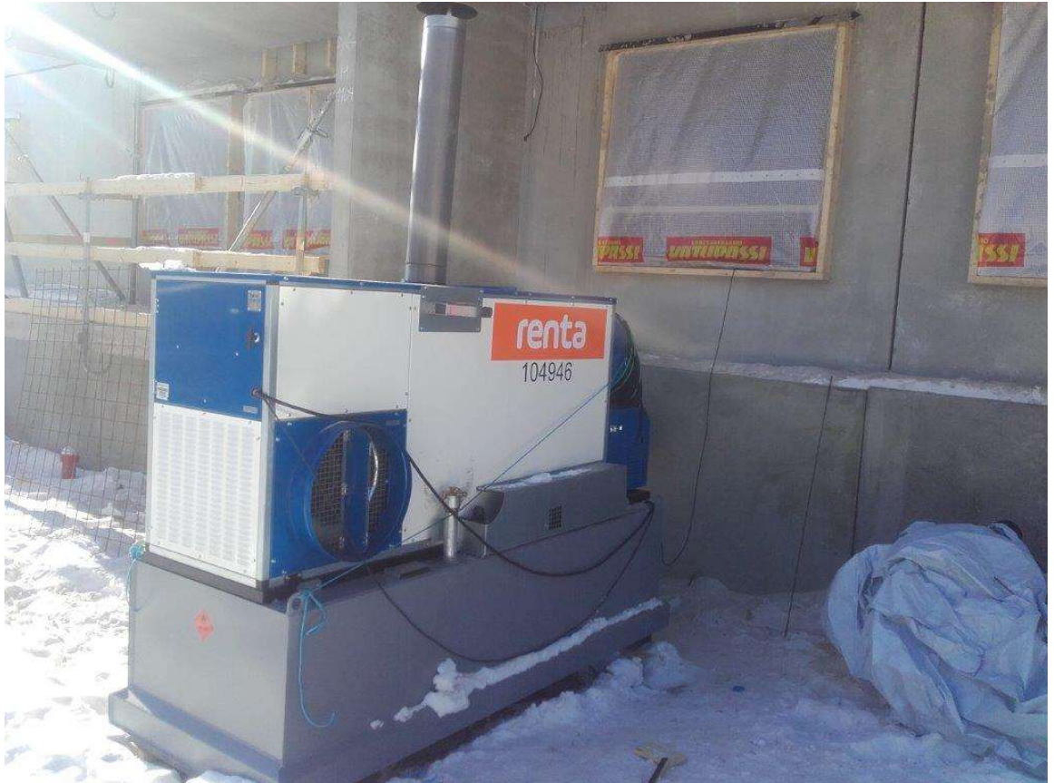
Kuva 5. Holvin alapuolen lämmitys polttoainekäyttöisellä lämmittimellä (Kuva: Miika Kylönen)
