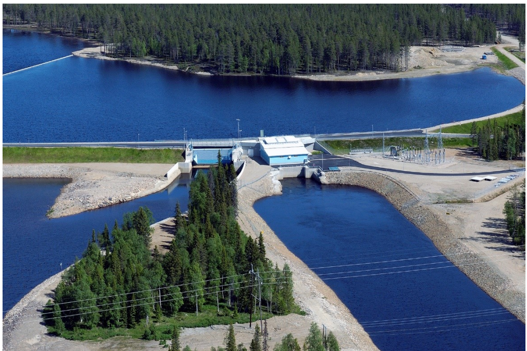
Kuva 4. Kelukosken voimalaitos (Kemijoki 2018).
