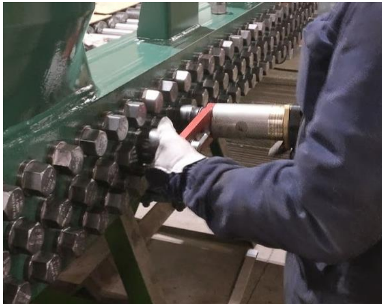
Kuva 28. Ruuvitulpan kiristys. Vastavoimavarsi tukeutuu viereisiin tulppiin. Kiristysmomenttina 415 Nm [31].
