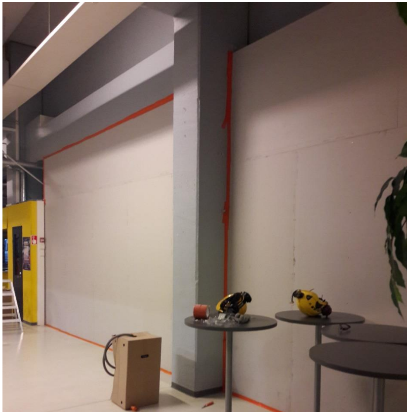
KUVA 21. Monitoimiareenan yhdysosan ja jäähallin välinen suojaseinä teipattiin tiiviiksi ennen mittauksen aloitusta. Kuva jäähallin puolelta. (Karhunen 2017.)
