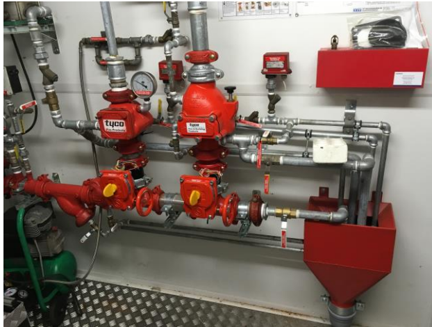
Kuva 9: Sprinkleri-laitteisto
