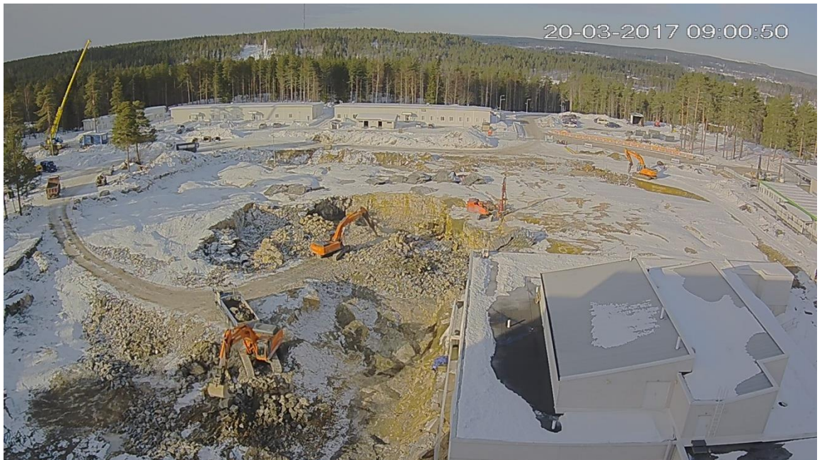
Kuva 5. Työmaa louhintavaiheessa (Kainuun uusi sairaala -allianssi. Kainua-kuvat.)
