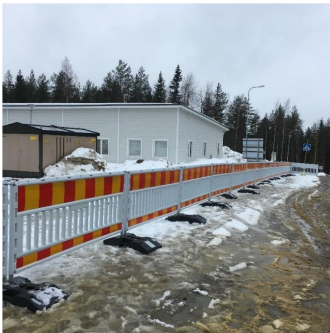
Kuva 6. Jalankulkuliikenne on eristetty ajoneuvoliikenteestä liikenteenohjausaidalla
