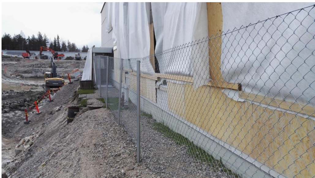
Kuva 9. Hätäpoistumistie järjestettynä kaivannon ja sairaalarakennuksen väliin
