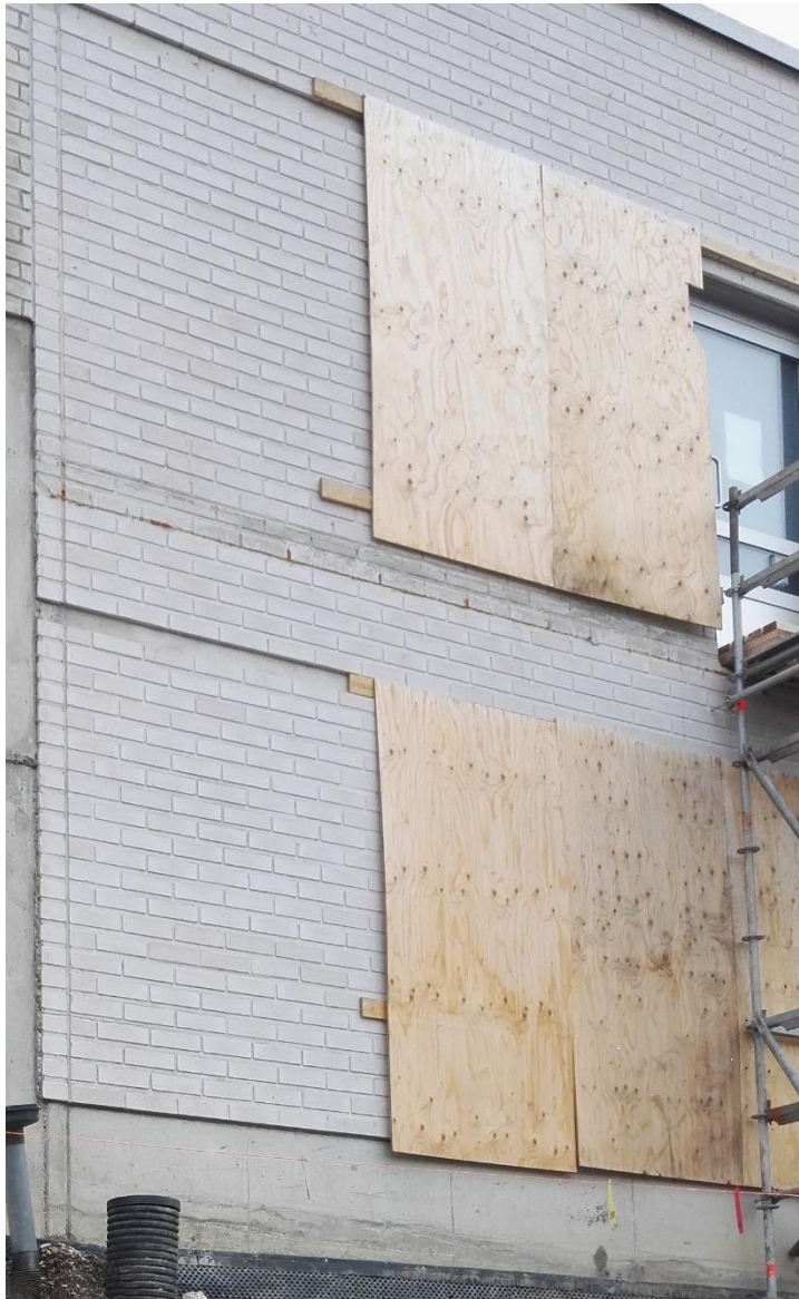
Kuva 11. Suojaukset teho-osaston ikkunoissa
