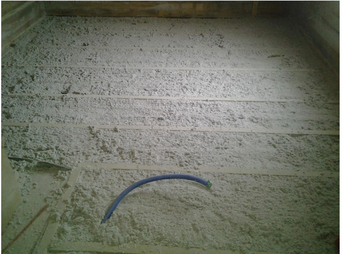
Kuva 11. Puhallusvilla puhallettuna ja tiivistettynä isommassa makuhuoneessa
