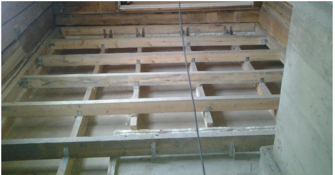
Kuva 10. Lattian runko pienemmässä makuhuoneessa
