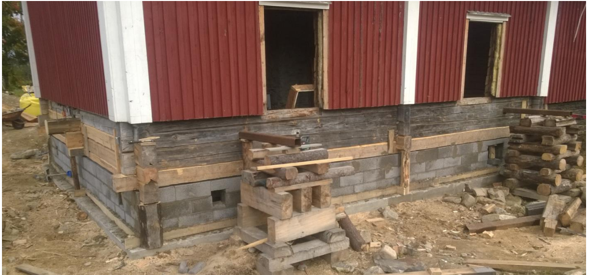
Kuva 18. Sokkeli muurattuna odottaa kuivamista, jotta talo voidaan laskea sen päälle
