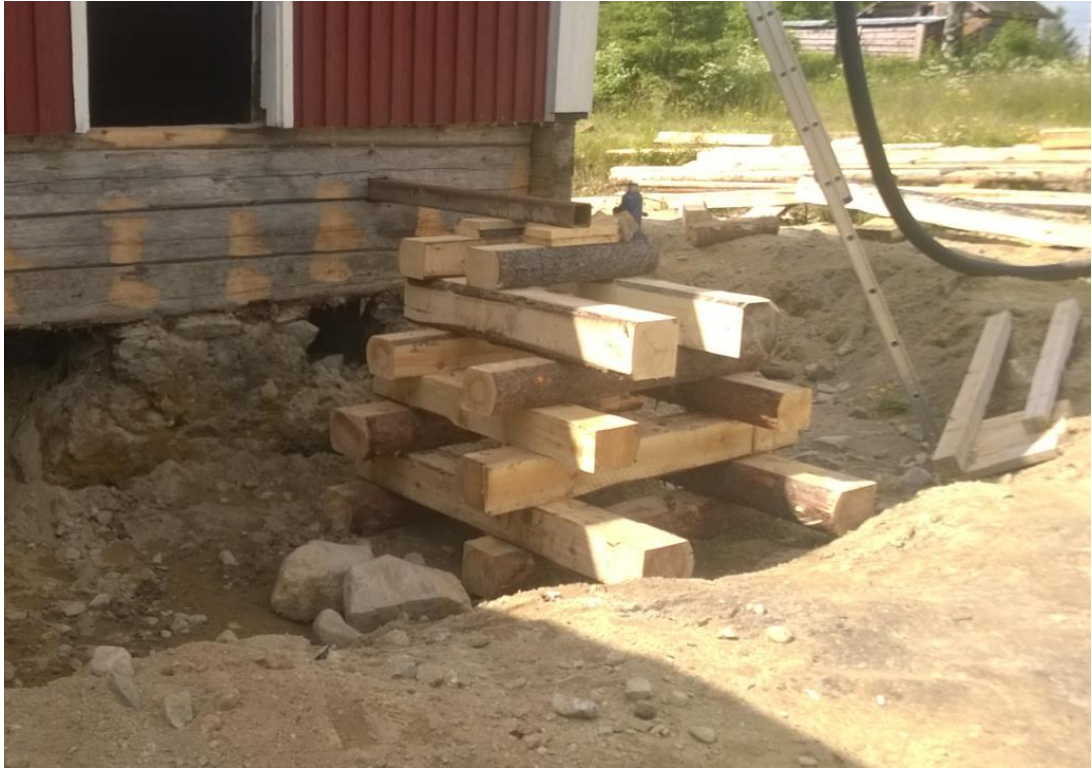
Kuva 14. Hirsipukki ja teräsputki jotka kannattelevat rakennuksen painoa
