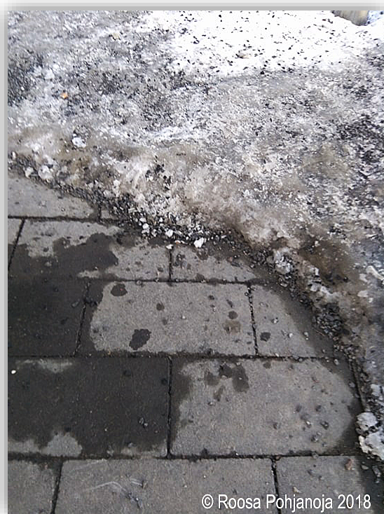
KUVA 23. Esimerkki lämmitetyn alueen reunalle syntyvästä jääkynnystä
