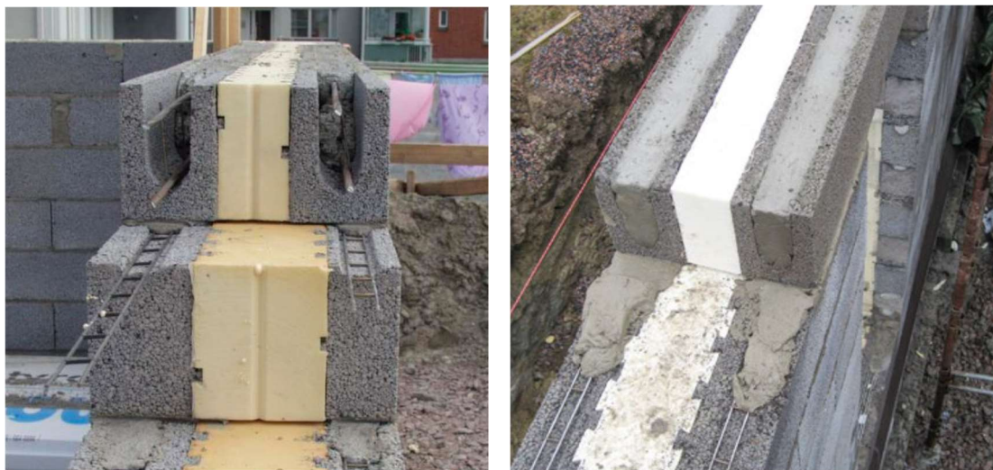
Kuva 6. Aukon ylityspalkki. Raudoitus, valu ja muuraussiteiden asennus. (Harkkokäsikirja).
