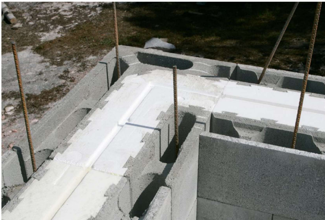
Kuva 2. Nurkissa käytetään kulmaharkkoja. Pystyraudoitukset tulevat valuonteloihin. (Kivitaloinfo.fi.)
