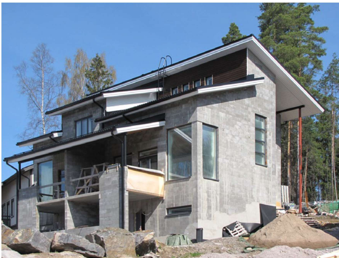
Kuva 3. Rakenteilla oleva harkkotalo (Kivitaloinfo.fi).
