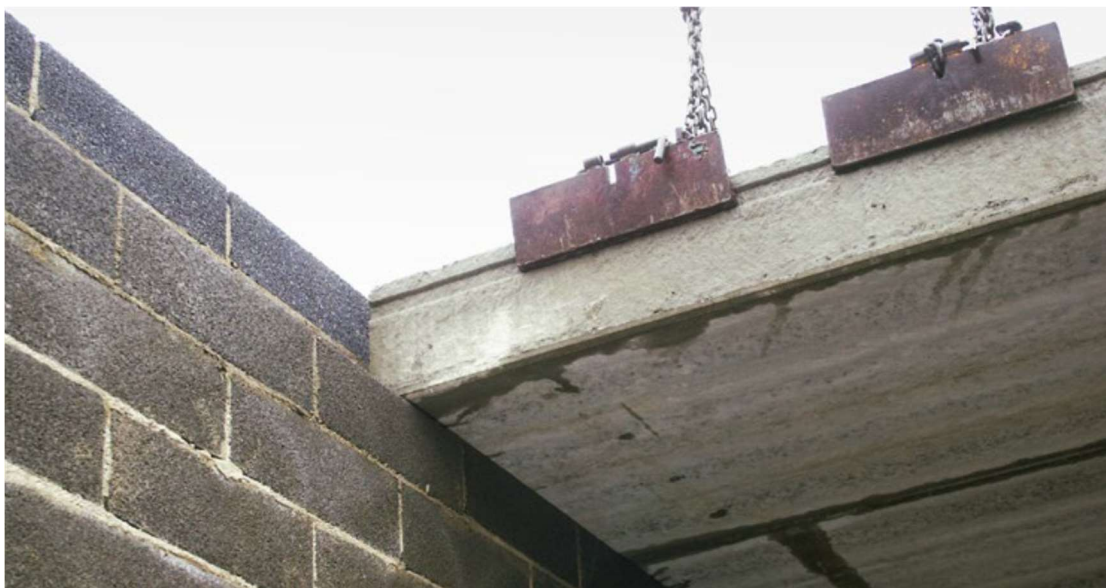
Kuva 12. Ontelolaatan asennus kevytsoraharkkouseinän päälle (kivitaloinfo.fi).
