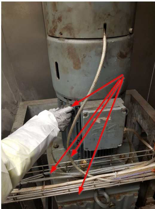
Kuva 16. Jäähdytyskuljettimen vaihdemoottorin kunnonvalvonnan mittauspaikat.
