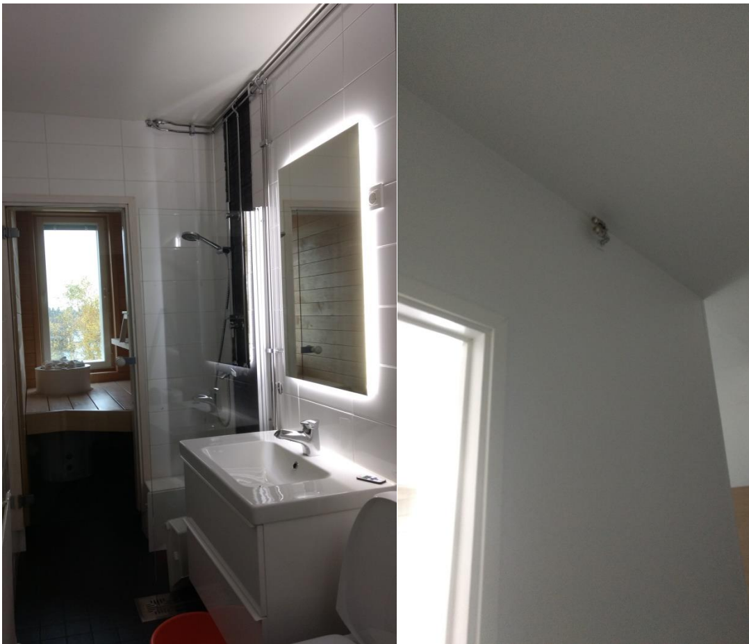
KUVA 9. Huoneiston pesuhuone ja käyttövesilähdöt
