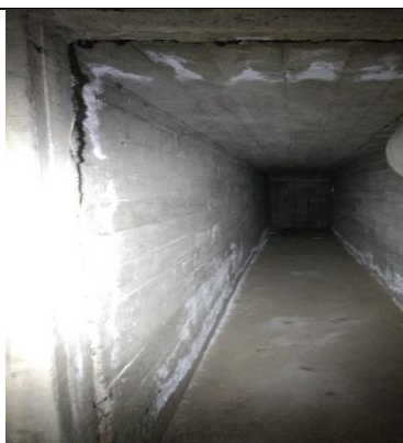
Väestönsuojan hätä- poistumistie
