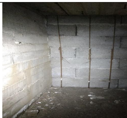
Väestönsuojan hätäpoistu- mistien murrettava oviaukko
