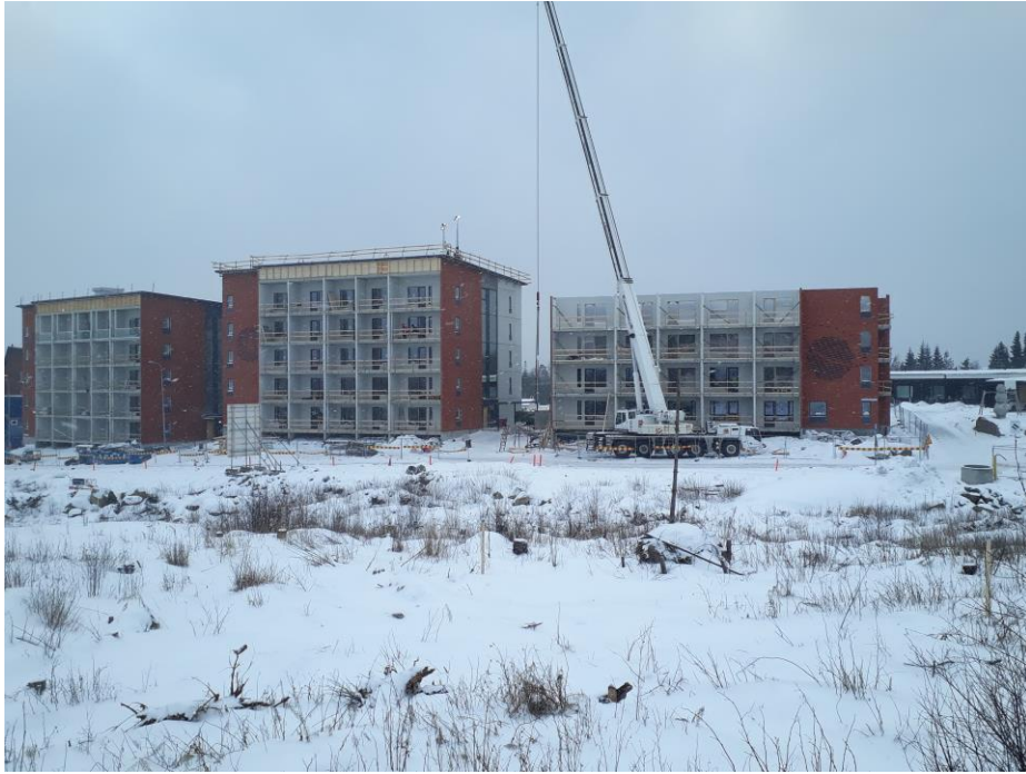
Kuva 9. Kuvassa nähdään rakennuskohde Fuusion rungon ollessa rakennusvaiheessa.
