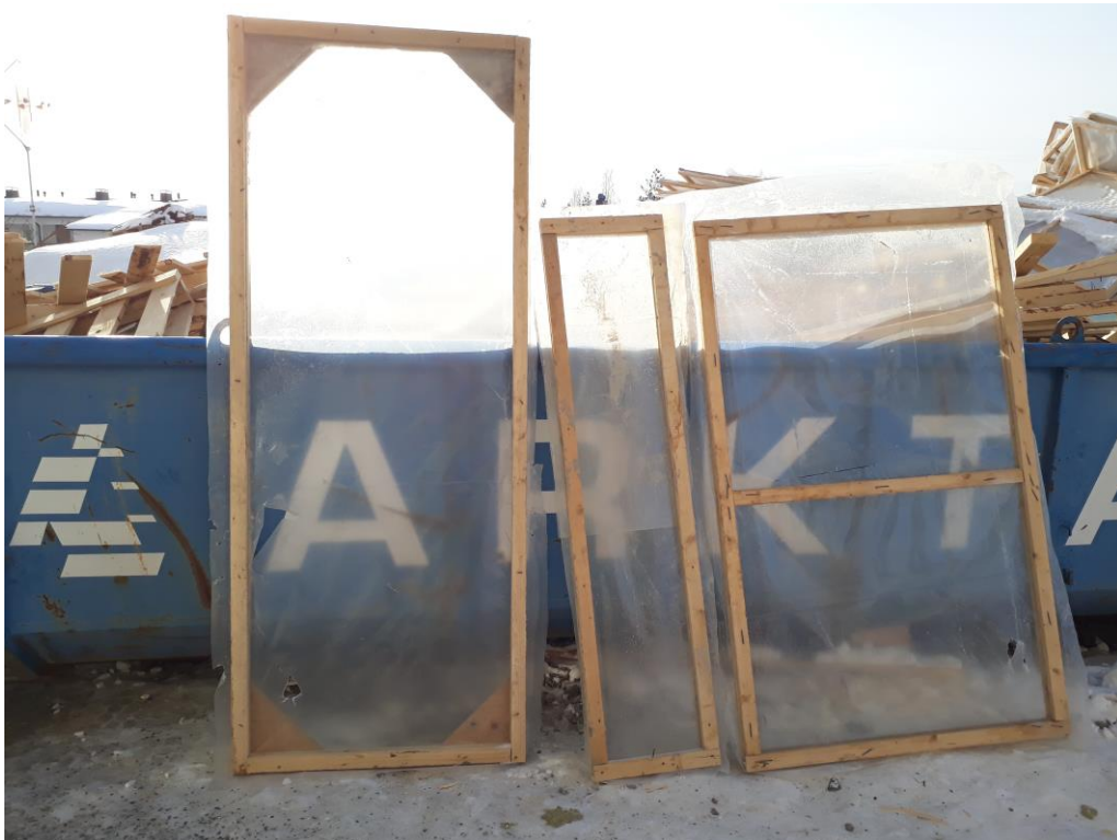
Kuva 12. Kuvassa nähdään väliaikaisia ikkuna- ja ovisuojia
