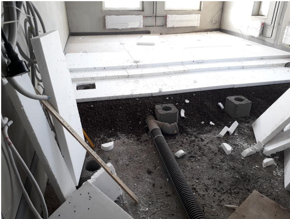
Kuva 3. Väestönsuojan yläpuolinen lattiarakenne
