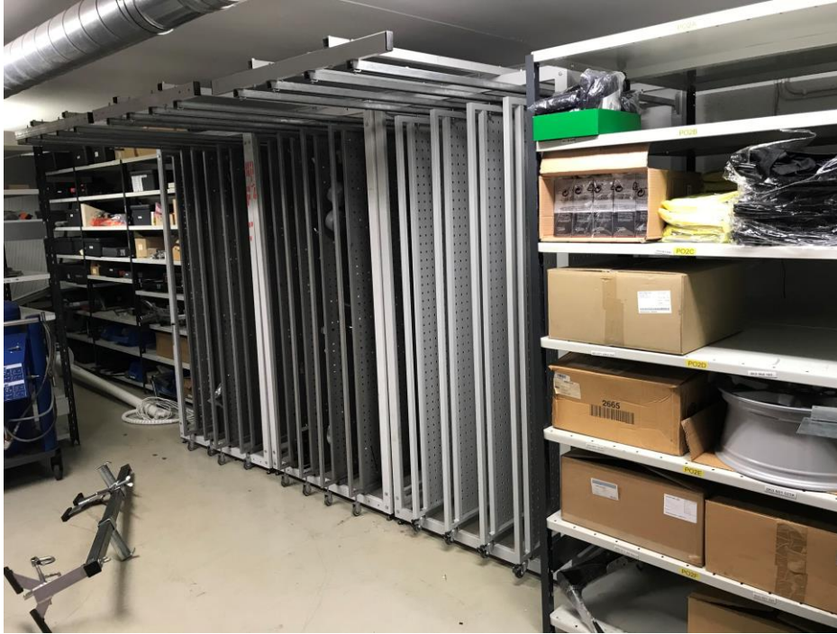
Kuva 11. Tilanne, kun vanha tasohylly on purettu ja uusi vetotaulu asennettu paikoilleen
