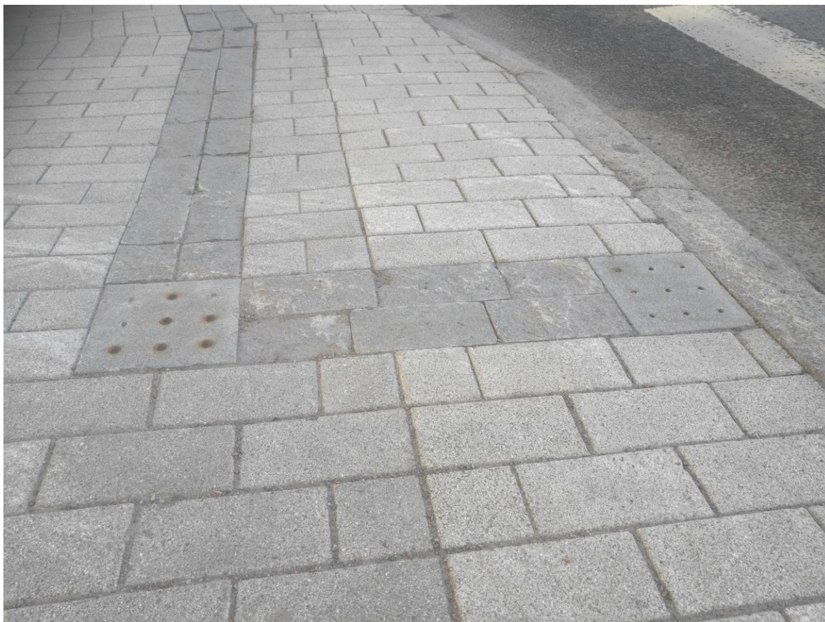
Kuva 1. Huomiolaattojen kupolit on aurattu irti. Myyrmäen asema.
