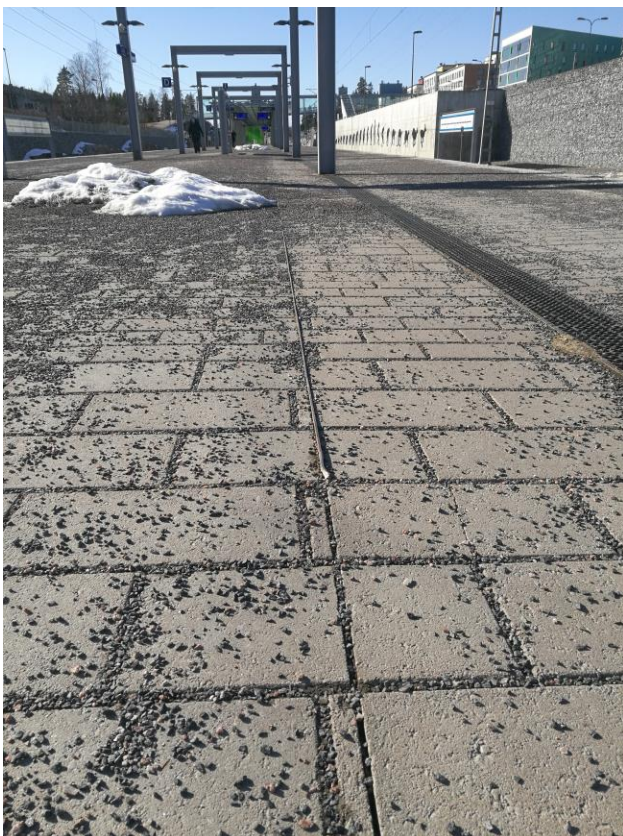
Kuva 2. Leinelän katkennut ohjauslista. Hiekoitushiekka vaikeuttaa listan havaitsemista.
