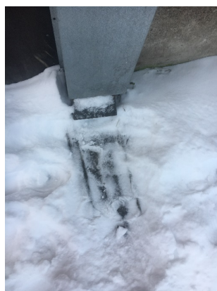
Kuva 4. Sadevesien poisto oli toteutettu betonikouruilla.
