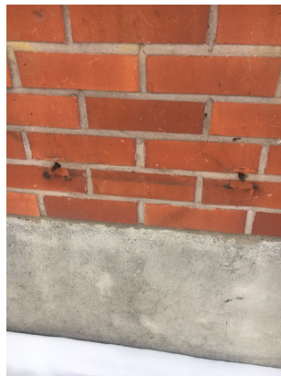
Kuva 10. Julkisivussa oli kaksi rautatappia.
