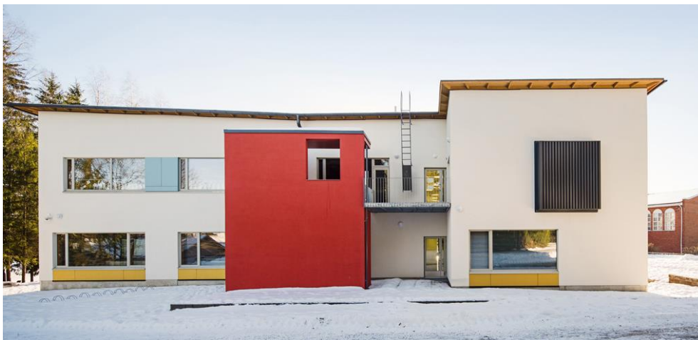
Kuva 13. Ilolan koulun laajennus. Kuva: A-Konsultit
