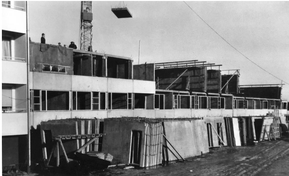
Kuva 4. Tampereen Kaleva-Sampon asuinrakennukset rakenteilla. Olli Vahtera.
