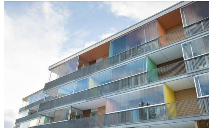
Kuva 31. Jakomäen purettujen rakennusten tilalle rakennetut uudet kaupungin vuokratilat.
