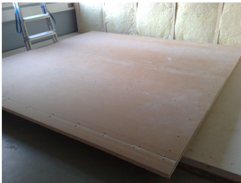
Kuva 6: Seinäelementti valmiina pystyyn nostamista varten
