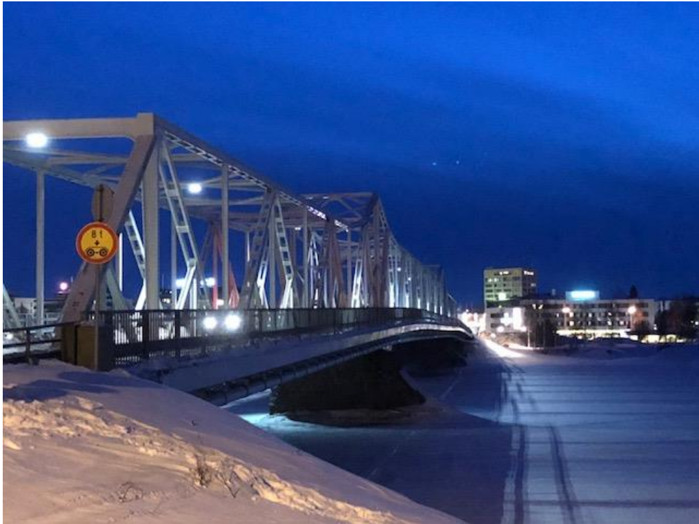
Kuva 1 Tornion vanha silta maaliskuussa 2018
