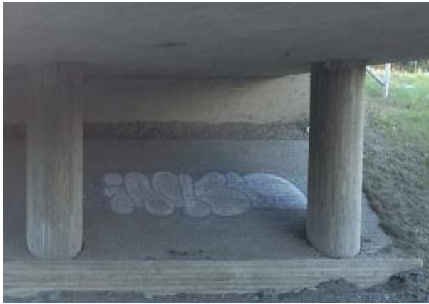
Kuva 5. Hyvässä kunnossa olevat välituet, merkintä A
