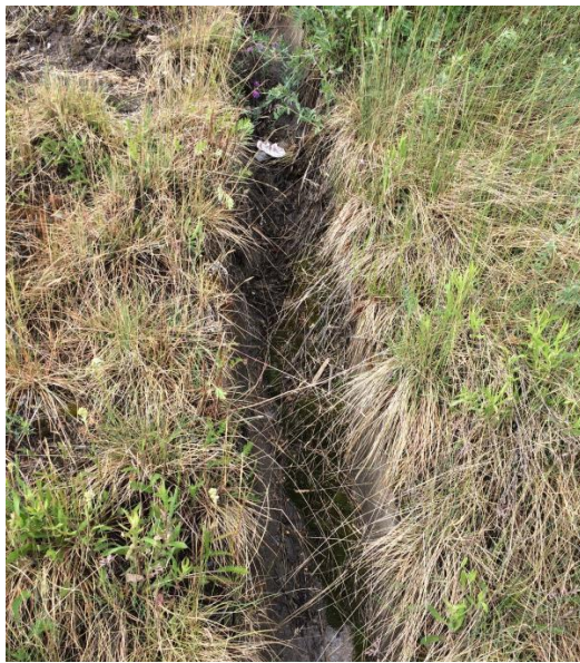
Kuva 25. Vesikouru heinittynyt, puhdistettava
