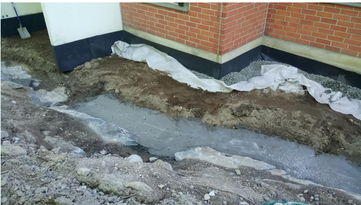
Kuva 5. Rakennuksen sokkeliin on asennettu patolevy, jonka vierustalle ajettiin sepe- liä. Näiden tehtävä on estää sivusuuntainen kosteuden kulkeutuminen rakenteisiin.
