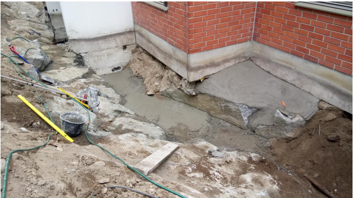
Kuva 3. Pintavedet ohjattiin kallistusvalulla pois seinärakenteen vierestä ja kallioon porattu railo tasattiin pohjalta betonivalulla, jotta vesi saadaan ohjattua kulkemaan valun päälle asennettavaan sala-ojaputkistoon.
