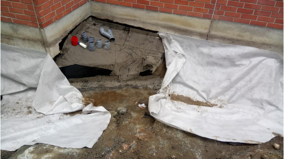
Kuva 4. Kallistusvalun päälle tehtiin bitumisively sekä asennettiin bitumikermihuopa, joiden päälle asennetaan suodatinkangas ennen salaojaputkien asennusta ja maanajoa. Valvojan tehtävä on huolehtia, että korjaustyösuunnitelmaa noudatetaan, joten piiloon menevien rakenteiden kuvaus on äärimmäisen tärkeää.
