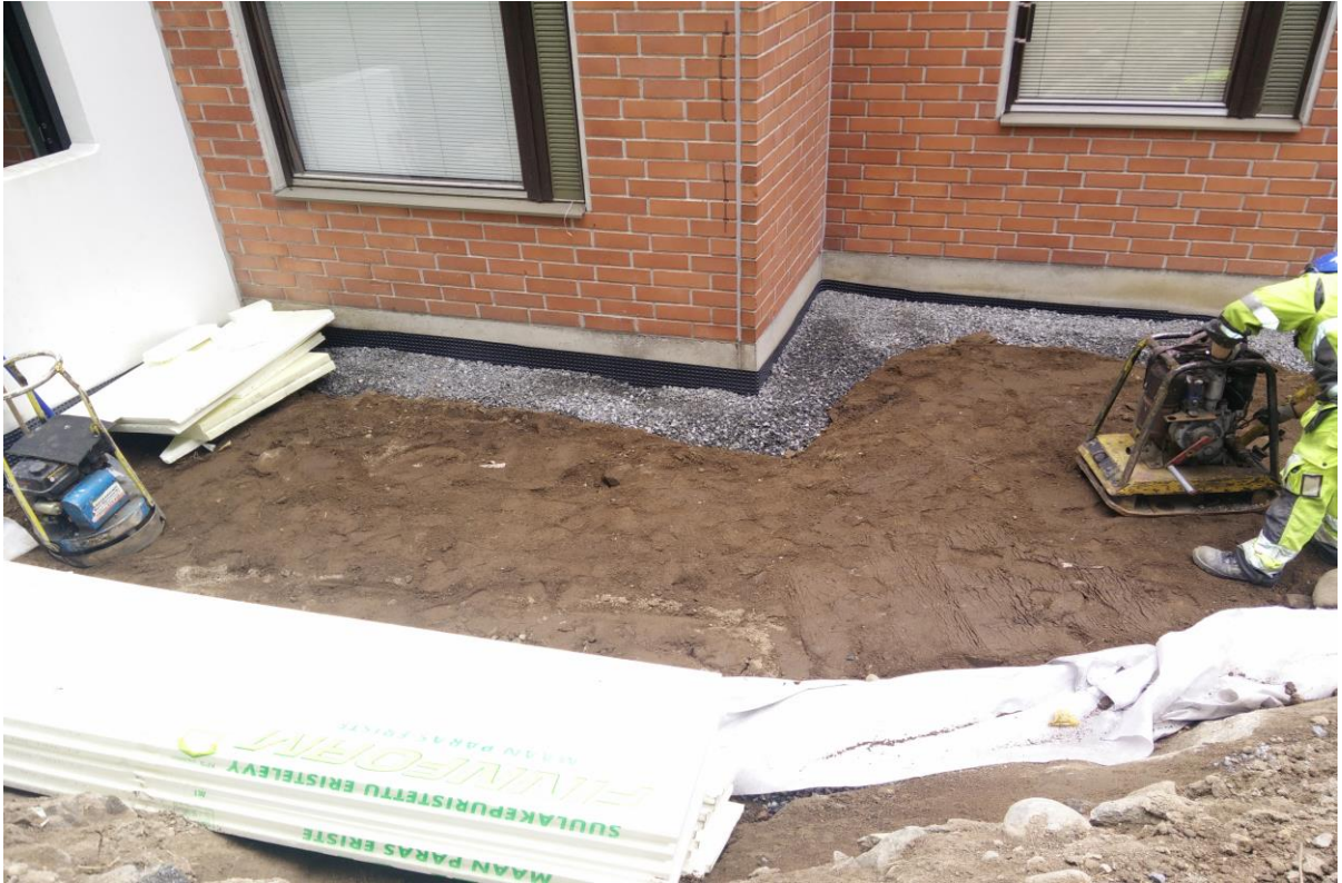
Kuva 6. Nurkka-alue maa-aineksen tiivistyksen yhteydessä.
