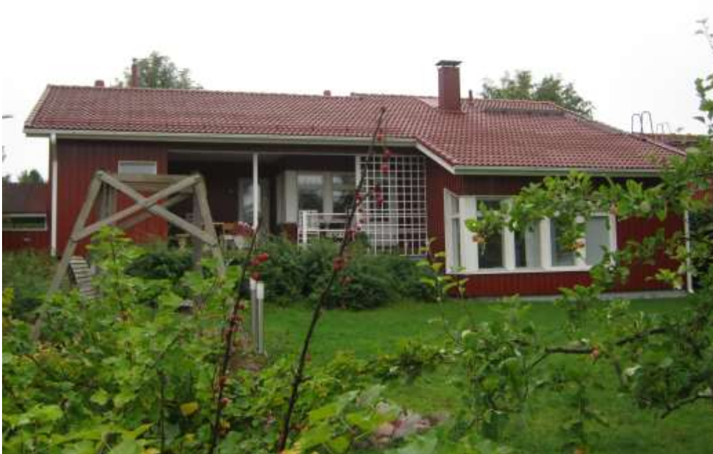
KUVA 14. Alkuperäinen rakennus takapihalta
