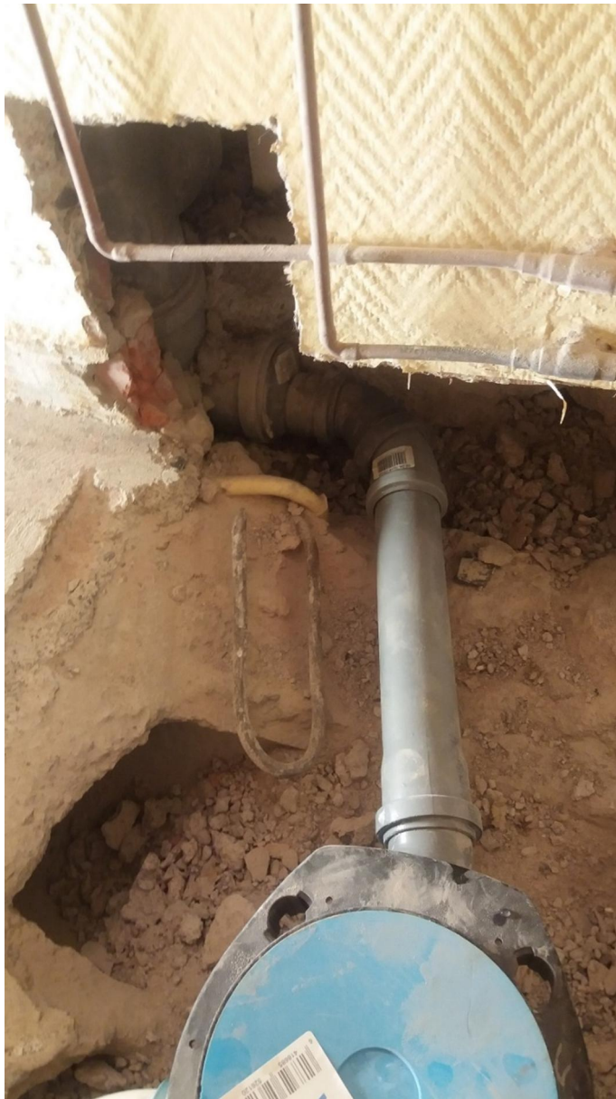
KUVA 11. Uusitun lattiakaivon viemäriin liittäminen (Kinnunen 2017)
