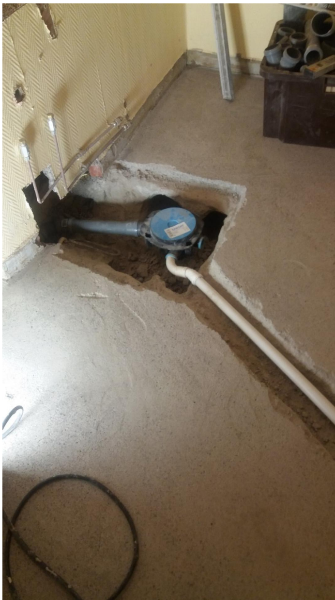
KUVA 8. Lattiakaivolle piikattu tila ja uusi lattiakaivo asennettuna (Kinnunen 2017)
