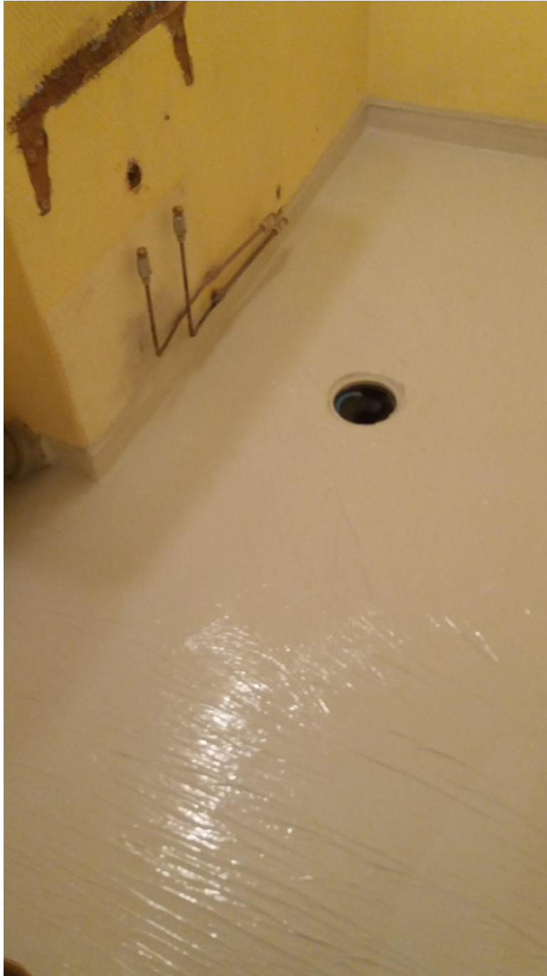
KUVA 11. Vesieristys tehtynä limittämällä vanhan rakenteen kanssa (Kinnunen 2017)
