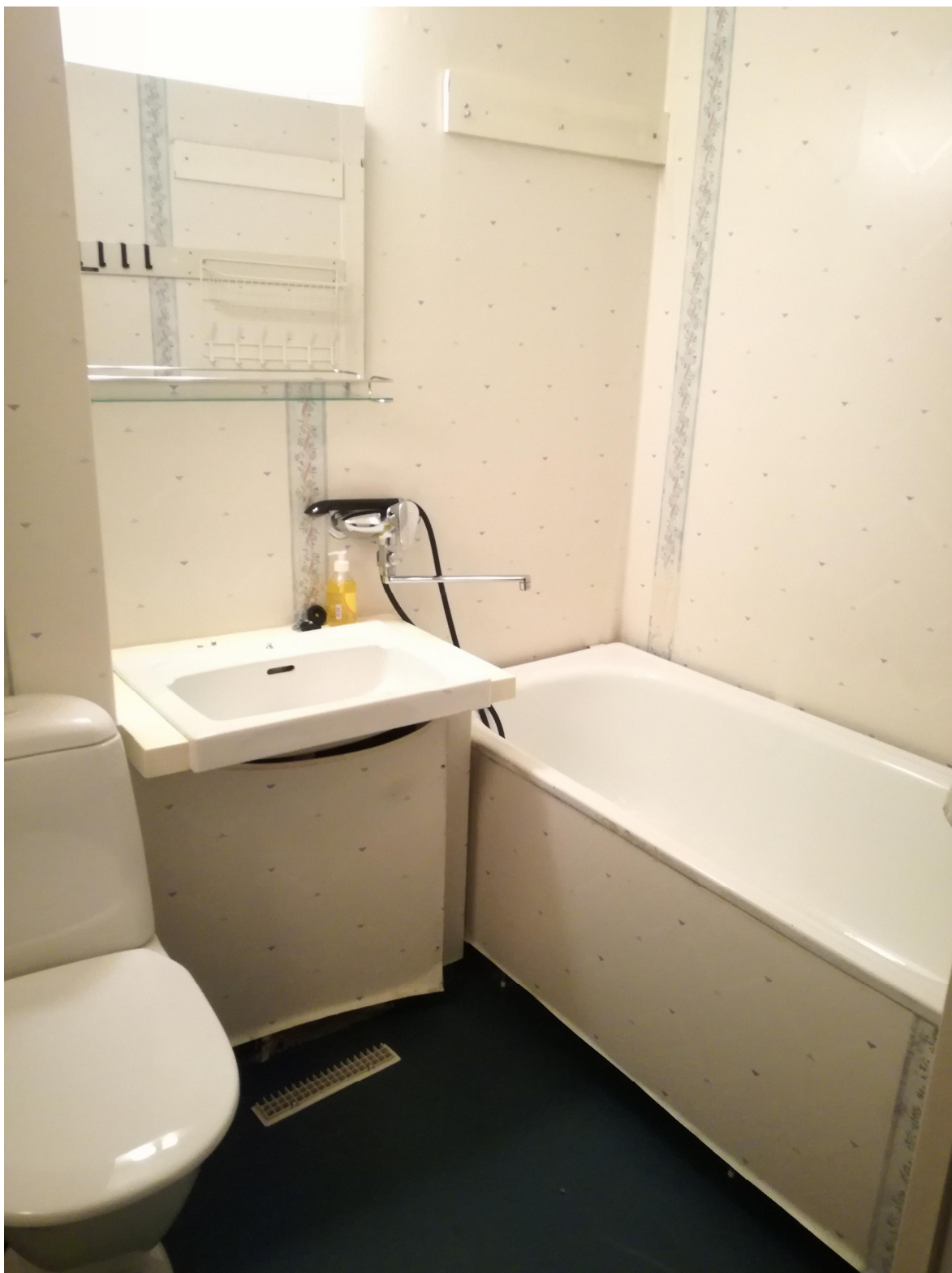
KUVA 2. Yleiskuva elementtikylpyhuoneesta ja seinäkaivon irrotetusta suojaritilästä (Kinnunen 2017)
