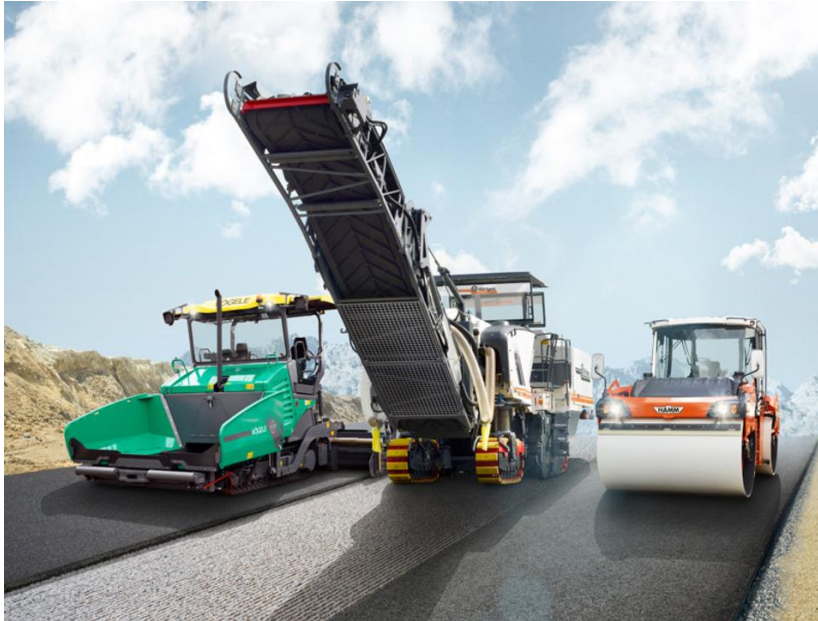
Kuva 4. Levityskalustoa, levittäjä, jyrsin sekä jyrä. [10.].
