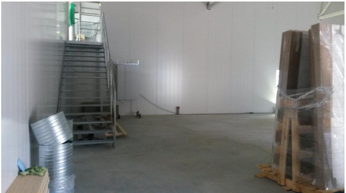
KUVA 5. Teknisen tilan rappuset.
