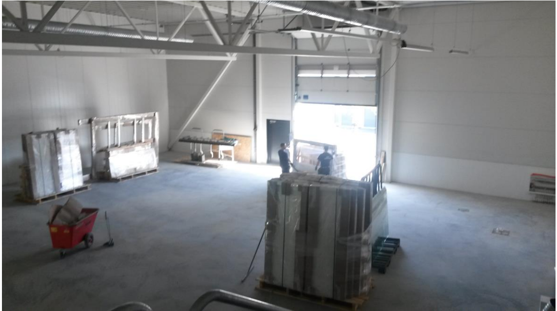
KUVA 5. Huoltohalli kuvattuna teknisen tilan rappusilta.
