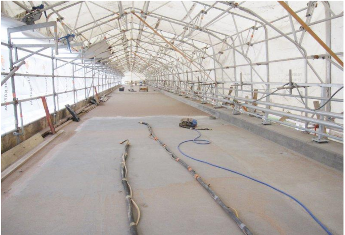
Kuvio 4. Sillan hiekkapuhallus sääsuojan sisällä (Esakon 2018)
