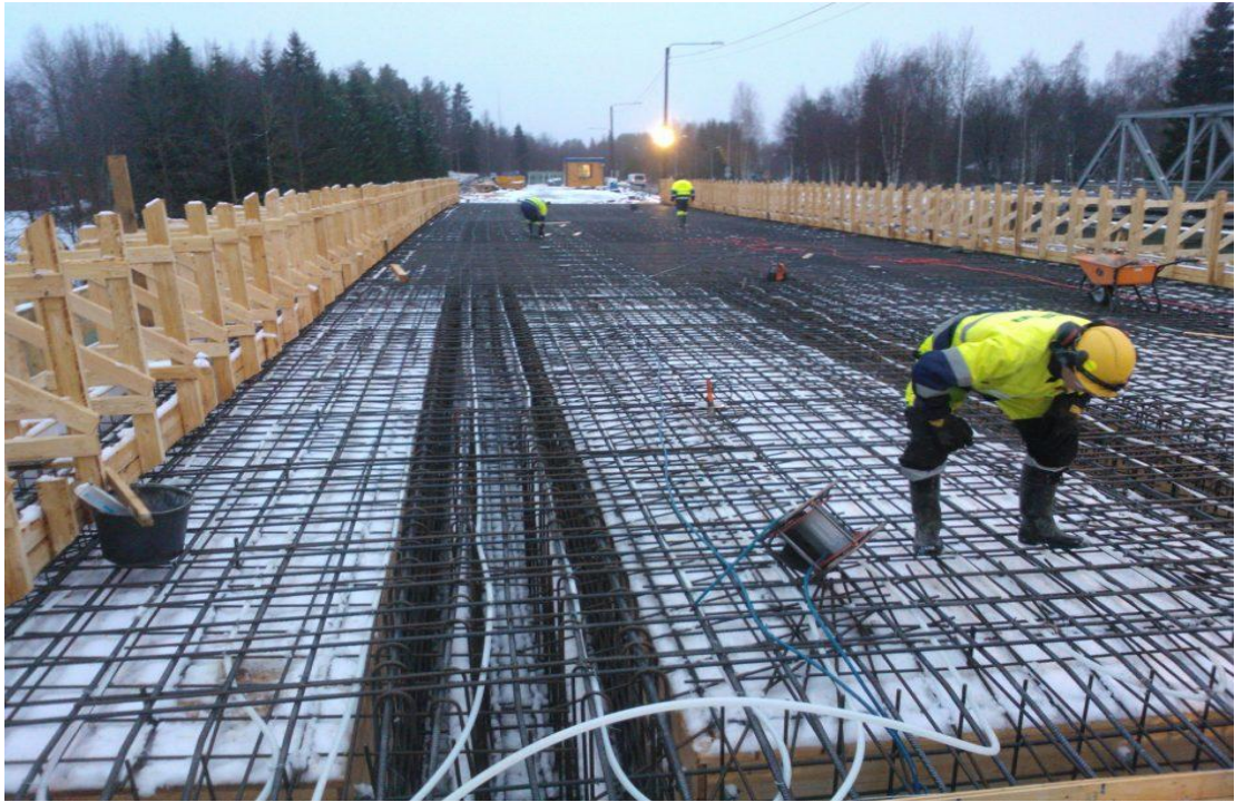
Kuvio 9. Sillan lämmityspotkien asennus (Savola 2018)
