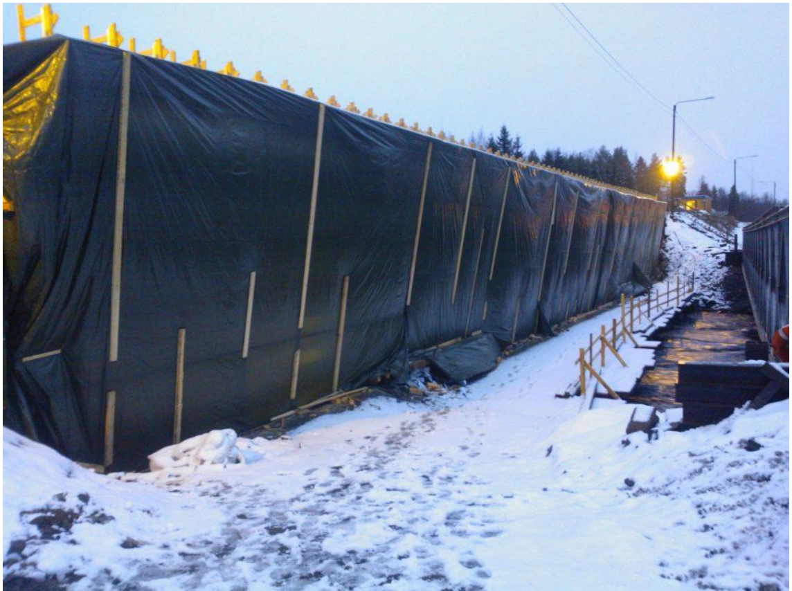
Kuvio 11. Sääsuojaus HeatWork -lämmityksellä (Savola 2018)
