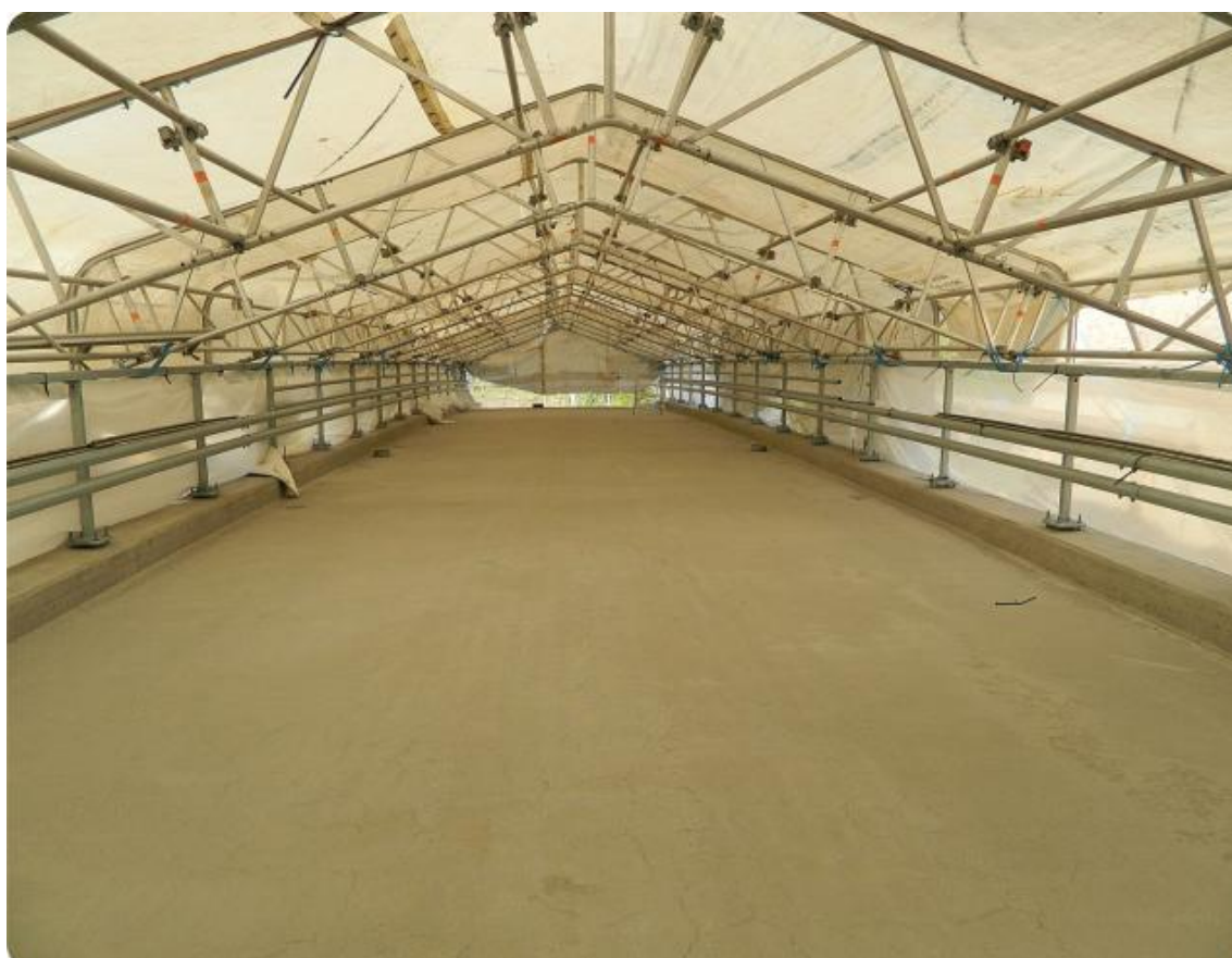
Kuvio 1. Alumiinirunkoinen sääsuoja (Liikennevirasto 2014, 1)
