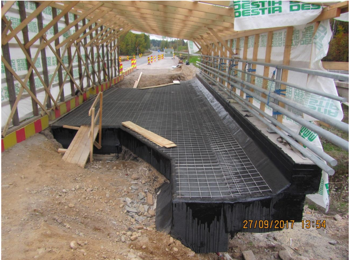
Kuvio 2. Paikallarakennettu puurunkoinen sääsuoja
