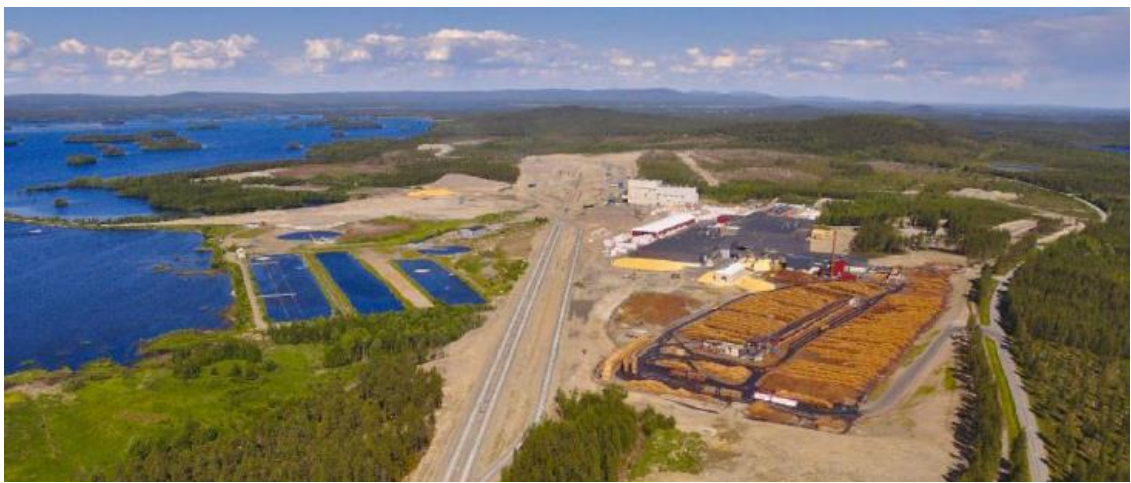
Kuvio 13. Havainne kuva alueesta. Kuvassa oikealla Lappi Timber Oy:n saha. Vaaleat rakennukset entisen sellutehtaan rakennuksia ja niiden vieressä vasemmalla puuterminaali. Biojalostamo ollaan sijoittamassa puuterminaalin taakse (FCG Suunnittelu ja tekniikka Oy 2017, 29)
