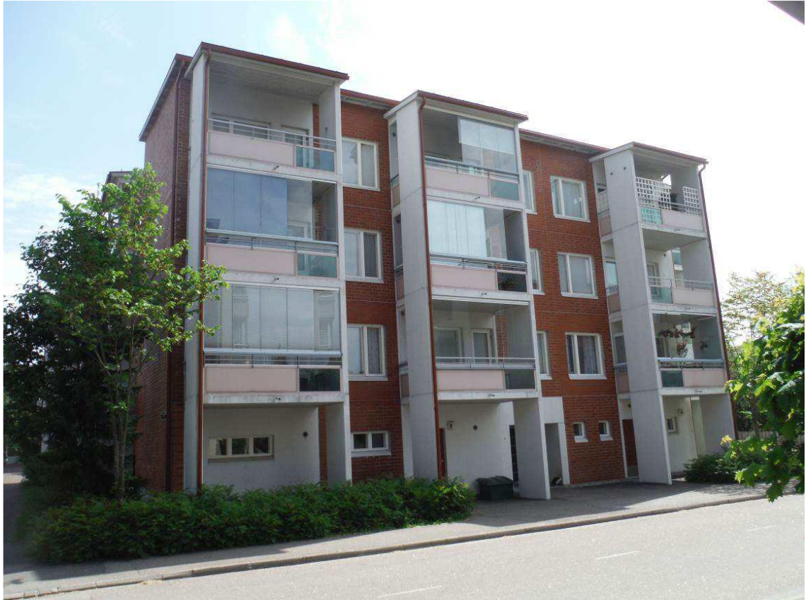
Kuva 1. Kotka Antinharjun peruskorjauskohde (Kuva: Joonas Kähkönen).
