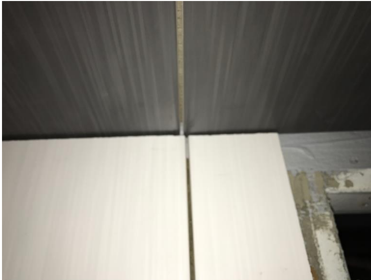
Kuva 8. Laatat hammastavat kulmassa (Kuva: Joonas Kähkönen).
