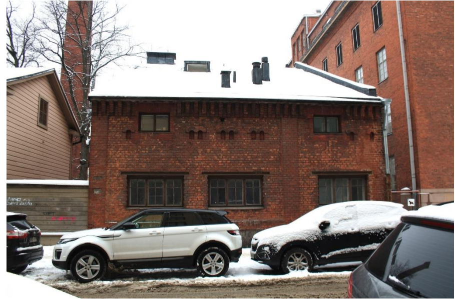
Kuva 1 Opinnäytetyön kohteena oleva Panimon varastorakennuksen osa Kalevankadulta katsottuna.
