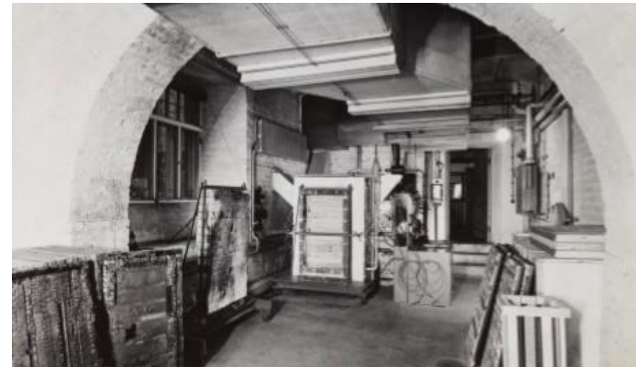
Kuva 14, Palolaboratorion pohjakerros ennen vuotta 1966, konepolttolaitos. Tiiliholvien läpi on viety kanavia ja teräspalkki. Lähde: Kottaraisen korttelin suppea rakennushistoriaselvitys s85 /TKKA
