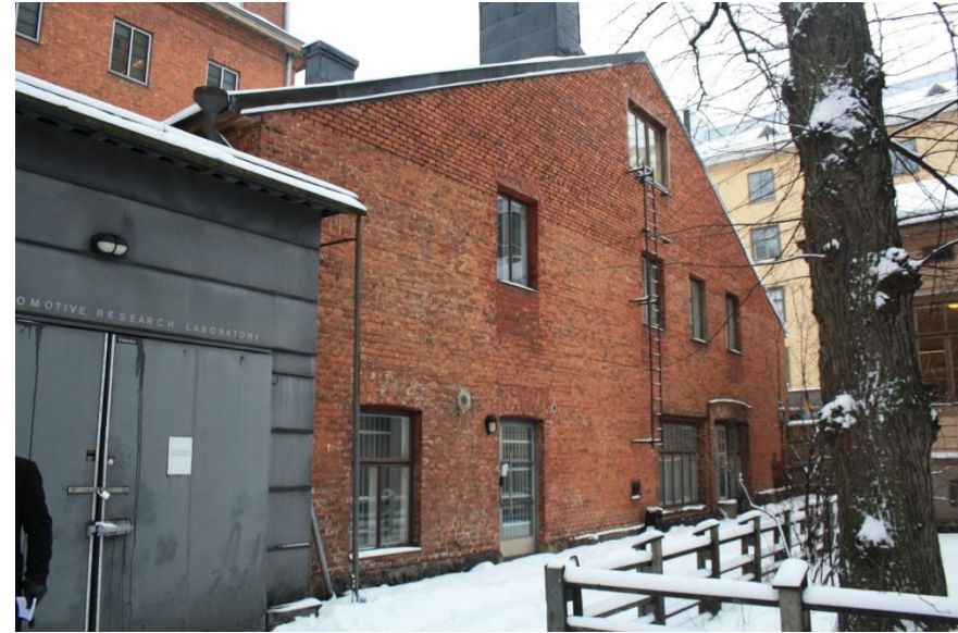
Kuva 16, Panimon varistorakennuksen sisäänkäynnit sisäpihan puolella.
