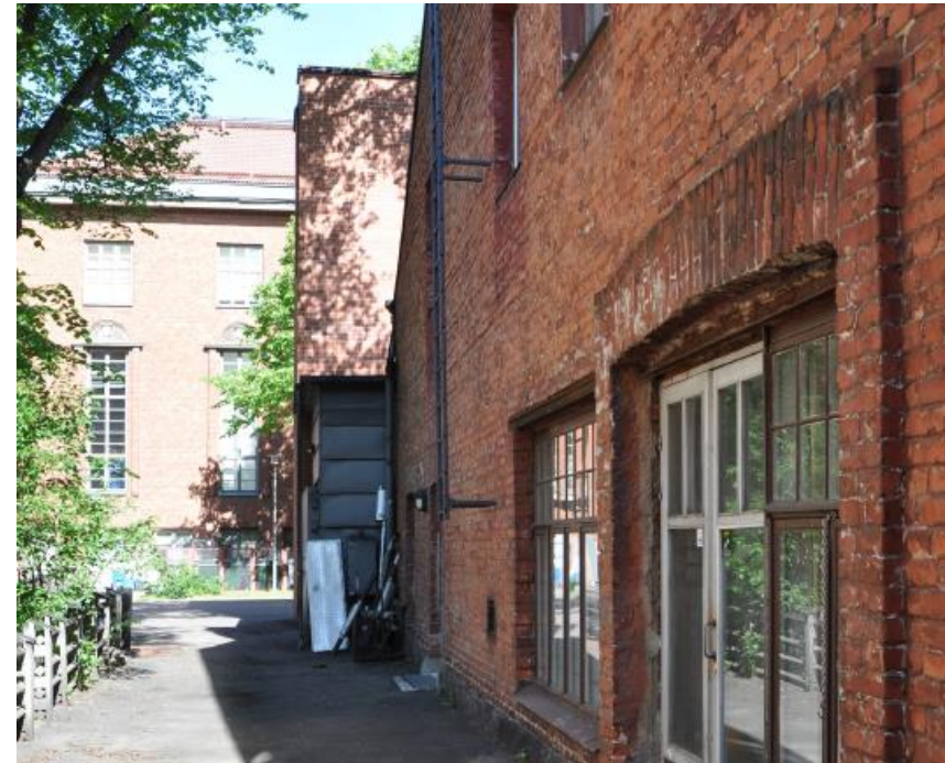
Kuva 31, sisäpihan puolelle jäävä aurinkoinen viihtyisä pihakaistale. Lähde: Kottaraisen korttelin suppea rakennushistoriaselvitys s 91
