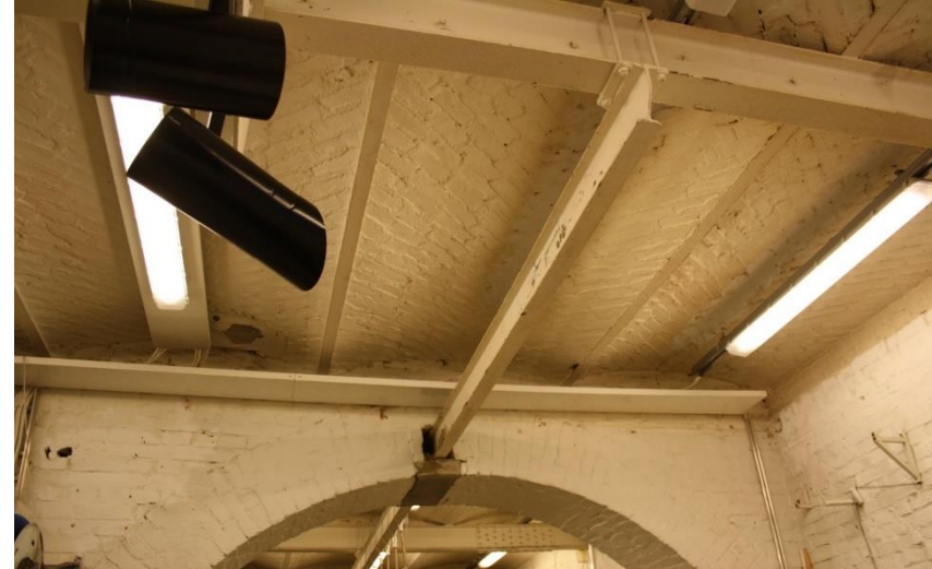
Kuva 33, Alimman kerroksen suuri tila. Holvikaaren läpi on viety teräspilari.
