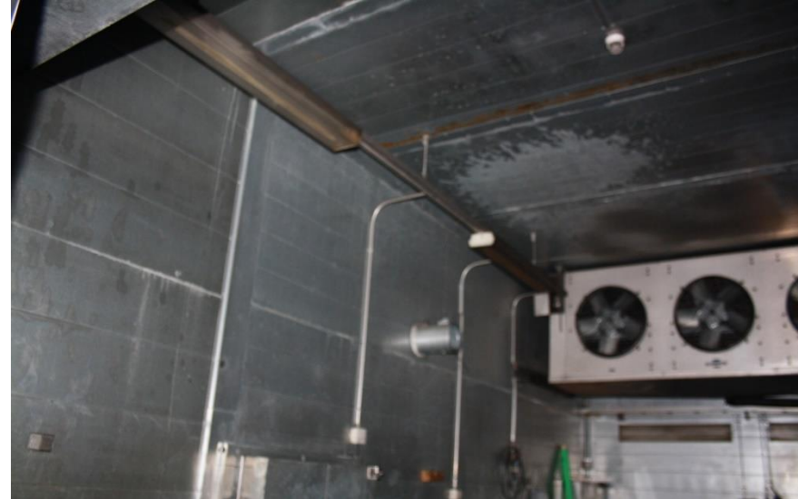
Kuva 21, Kylmä- ja kuumamittauslaboratorion sisäpintoja.
