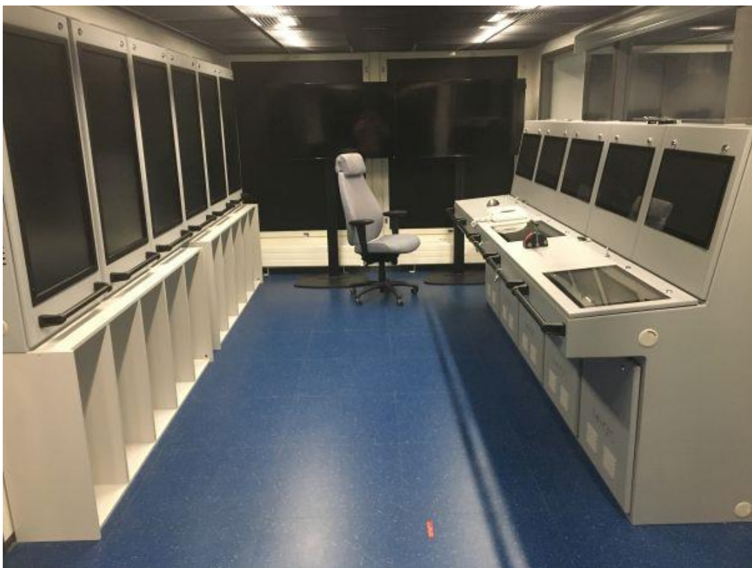
Kuva 3. Konevalvomo ja päätaulut (M. Heino 2018).
