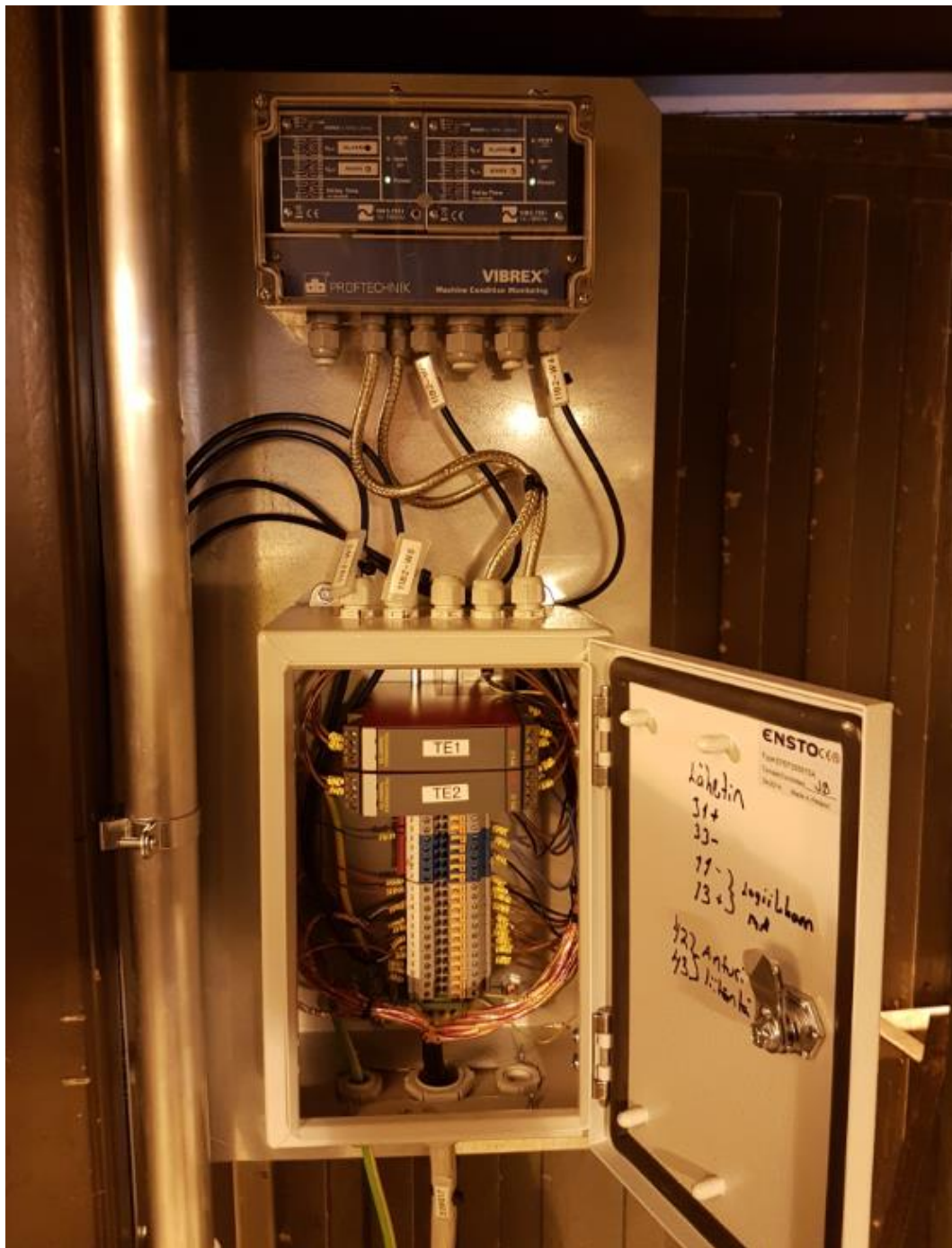
Kuva 8. Värähtelymittauslaitteisto, lämpötila-anturien lähettimet sekä kytkentäkotelo.
