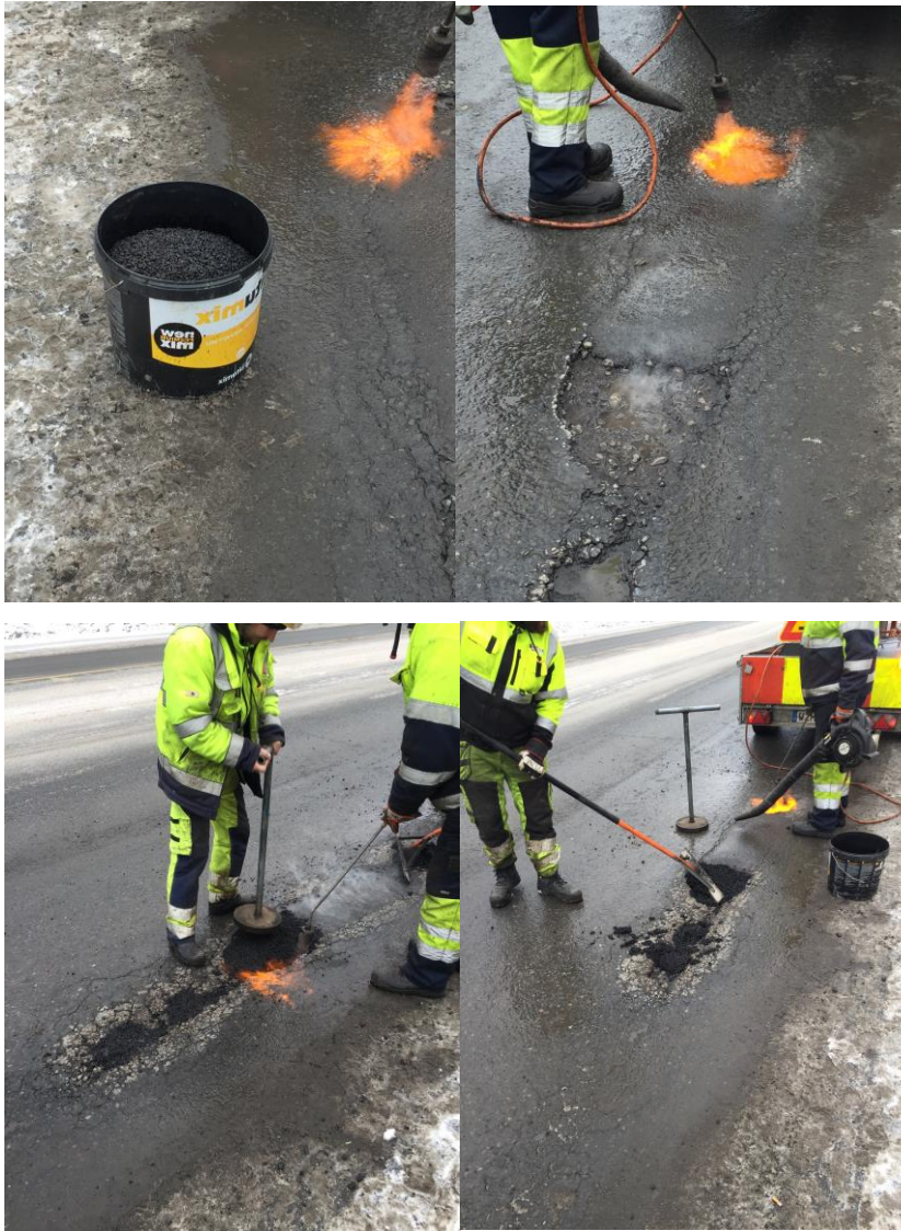
KUVA 6. Kylmäpaikkauksen työvaiheet. (Kuva: Tommi Sulin 2018).
