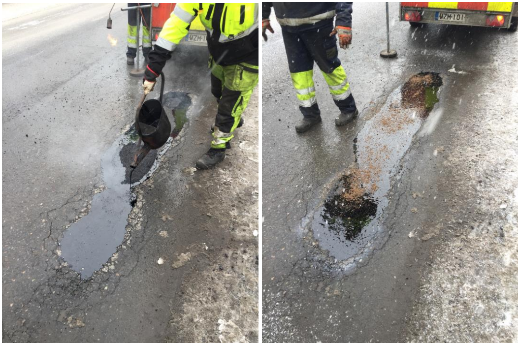
KUVA 7. Kuvassa reikäpaikkauksen viimeistelyä bitumilla sekä karkeutus. (Kuva: Tommi Sulin 2018).
