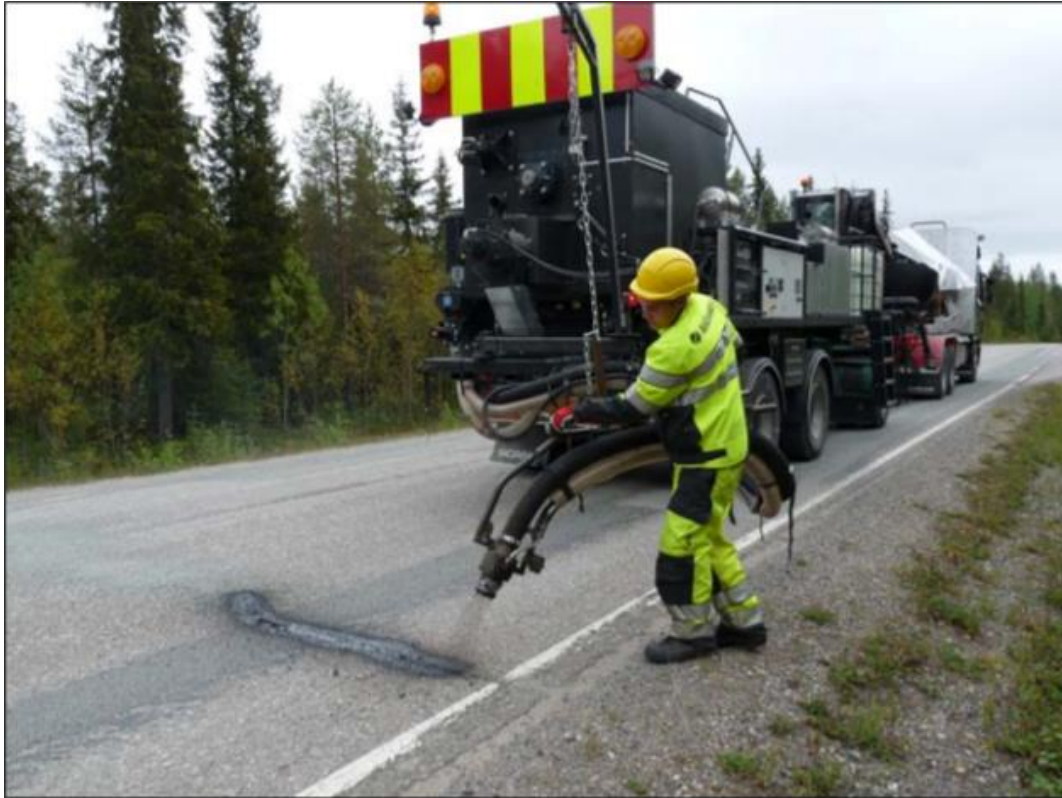
KUVA 11. Sirotepuhalluspaikkauksen tekeminen ja käytettävä kalusto (Kuva: Tiehallinto, 2009)
