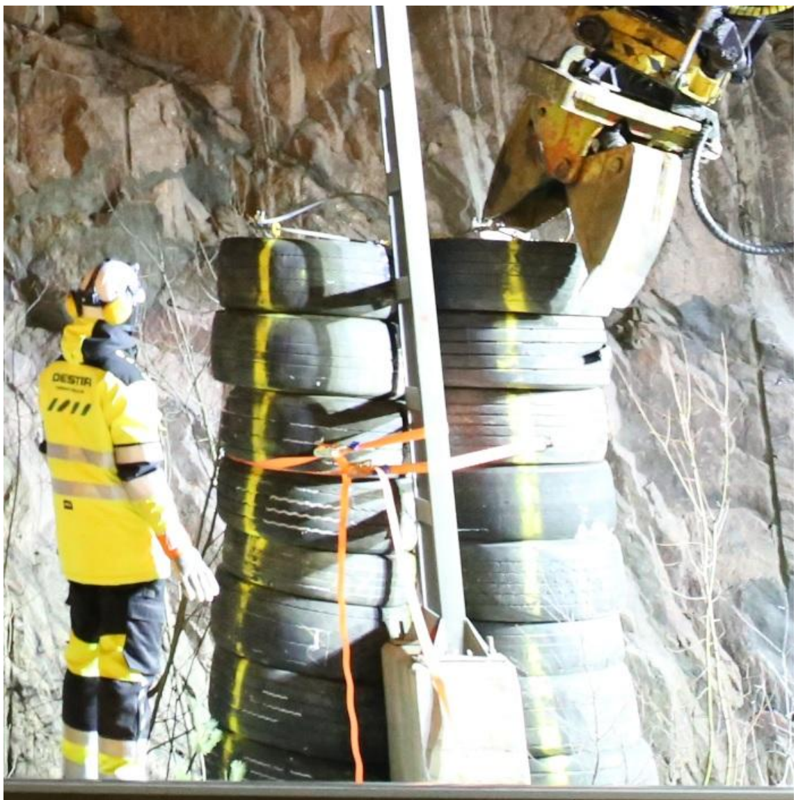
Kuva 9. Pylväiden suojaukseen käytettävien rengastornien paikalleen asennus käynnissä
