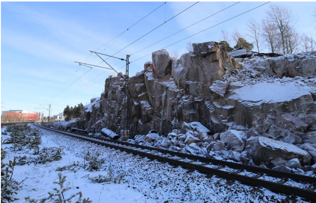
Kuva 11. Louhittava kallioseinä ja sen välittömässä läheisyydessä oleva itäisen raiteen ajolankojen pylväs
