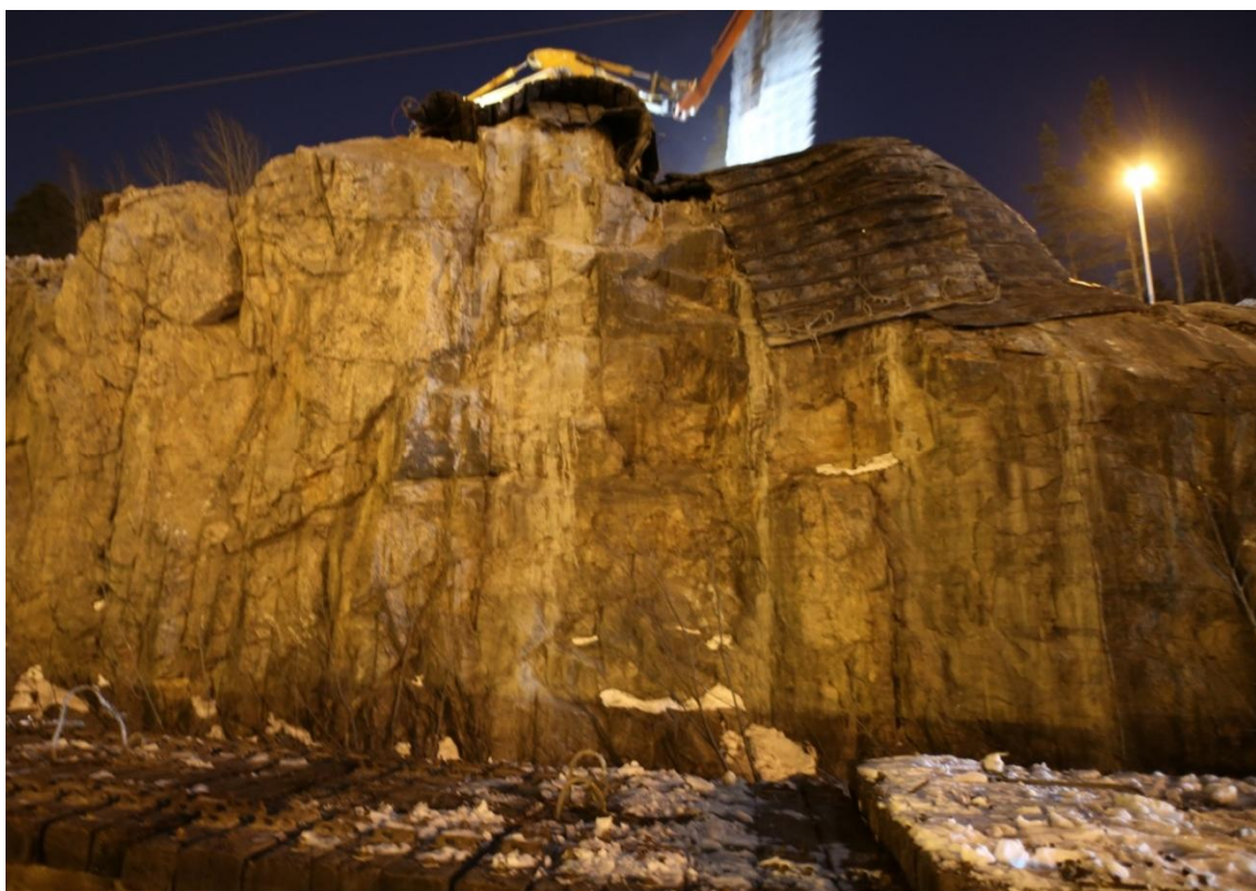
Kuva 5. Räjätettävän kentän peittäminen käynnissä.
