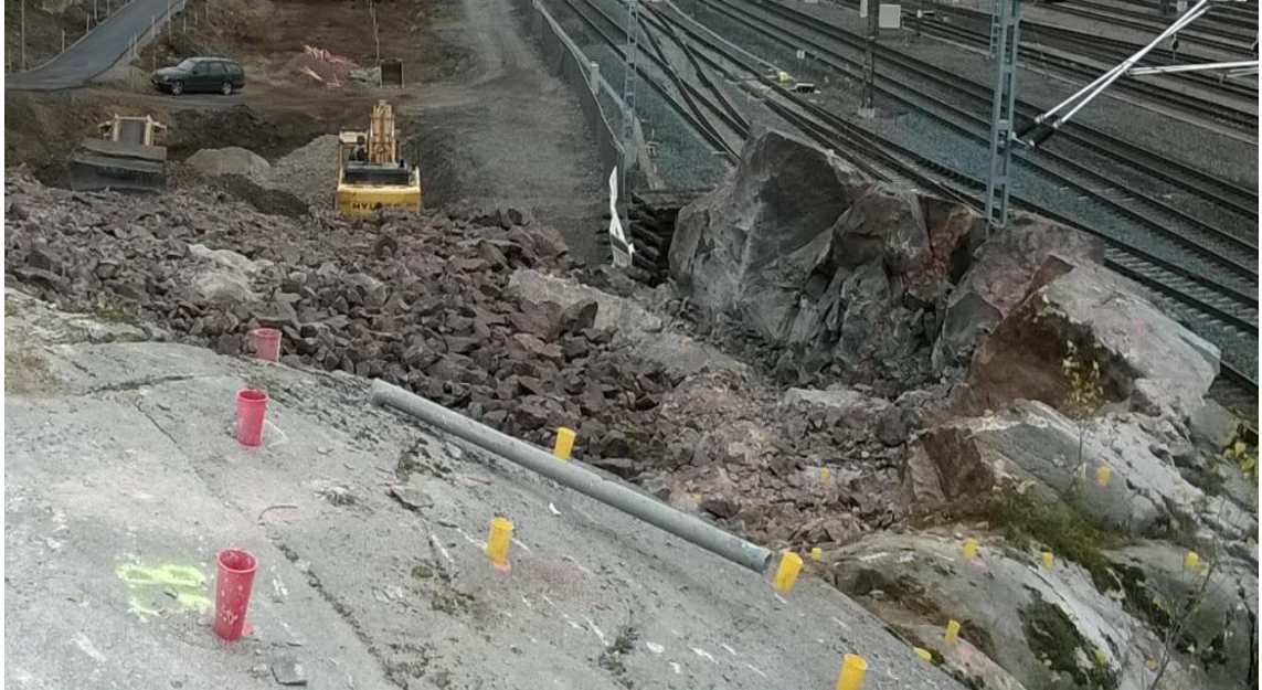
Kuva 4. Kuvassa näkyy radanpuoleisen laidan reuna, jonka vieressä on räjäytetty kenttä
