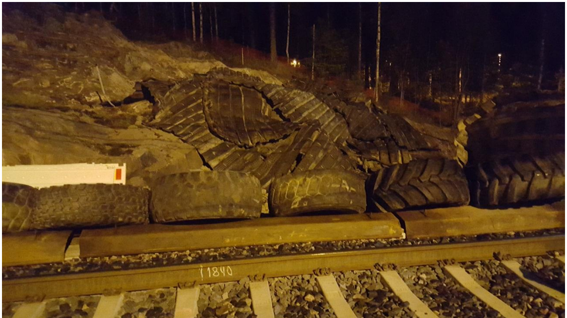
Kuva 10. Edustalla kaapelikourun suojaus, taustalla peitettynä räjäytettävä kenttä.
