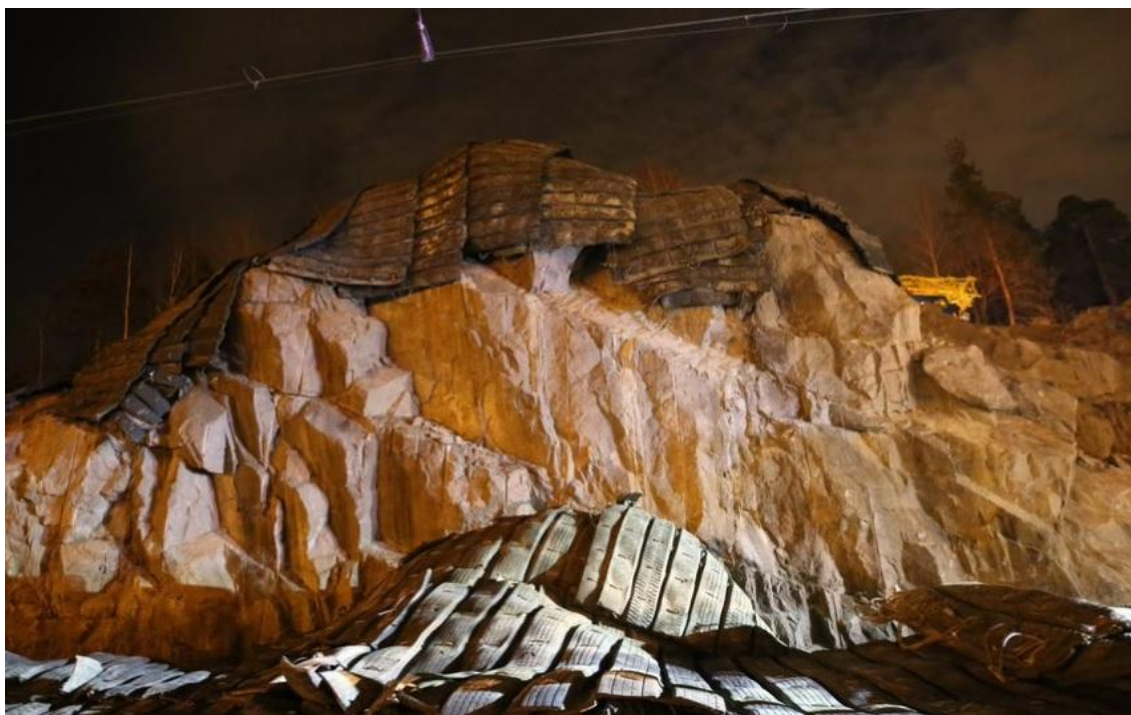
Kuva 12. Räjätettävä kenttä peitetty, rata suojattu ja pylväs siirretty
