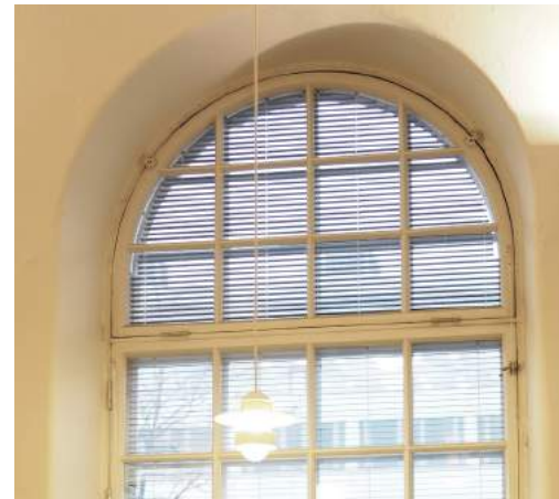
Puiset maalatut ikkunan karmit
