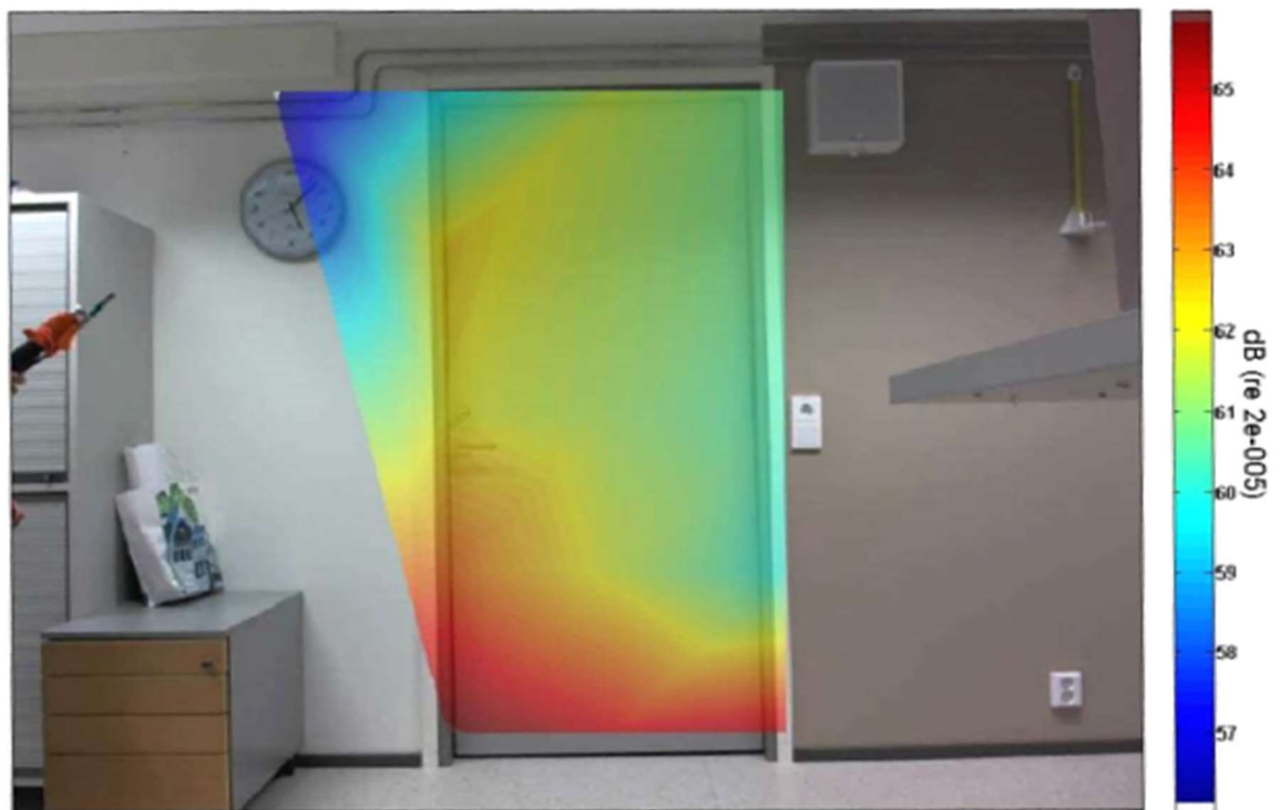
Kuva 19. Tilojen D107/D111 välinen ovi (liite 1).
