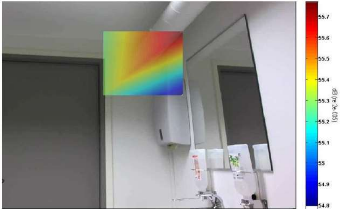
Kuva 23. Tilojen D112/D107 välinen IV-läpivienti (liite 1).
