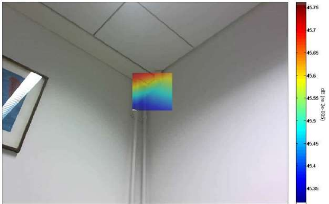
Kuva 26. Tilan D115 Patterien lämpöputkien läpivienti (liite 1).
