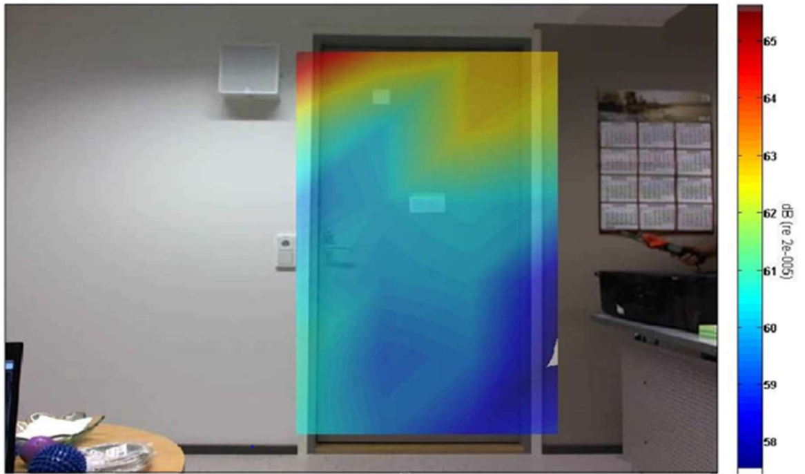
Kuva 24. Tilojen D115/D114 välinen ovi (liite 1).
