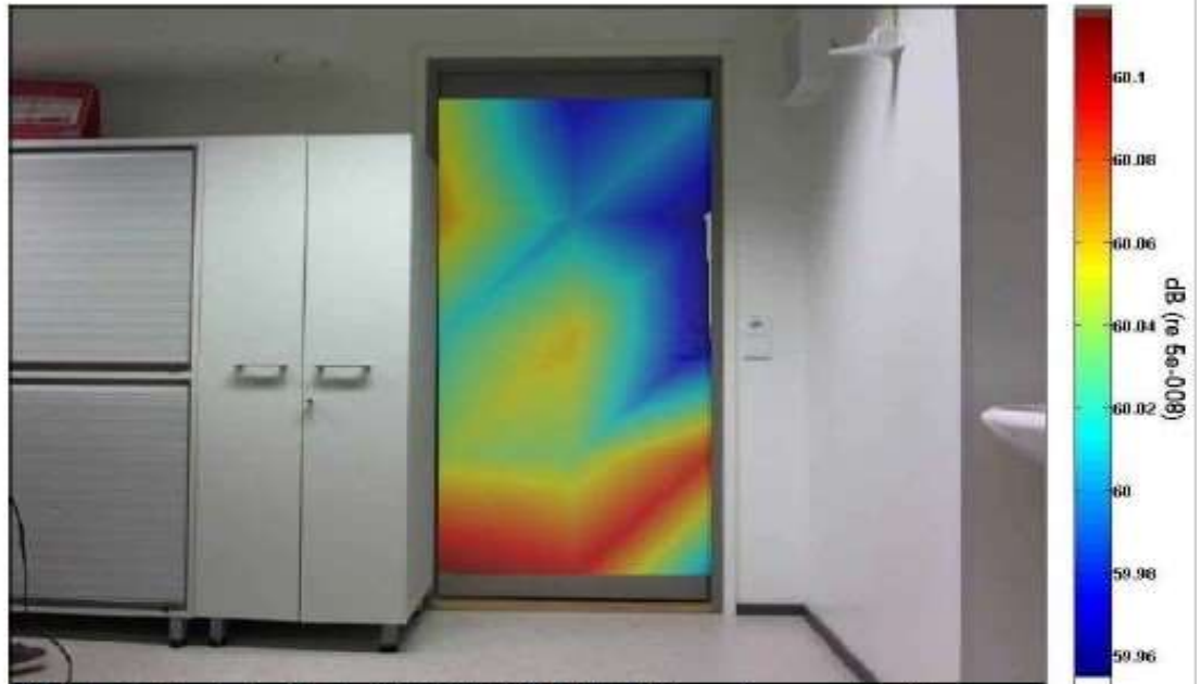
D110, ovi. Desibelivaihteluväli: 59,96-60,1 dB. Minimaalinen vuoto näkyy saranapuolen alanurkassa. Näin pienellä vuodolla ei käytännössä kuitenkaan ole merkitystä.
