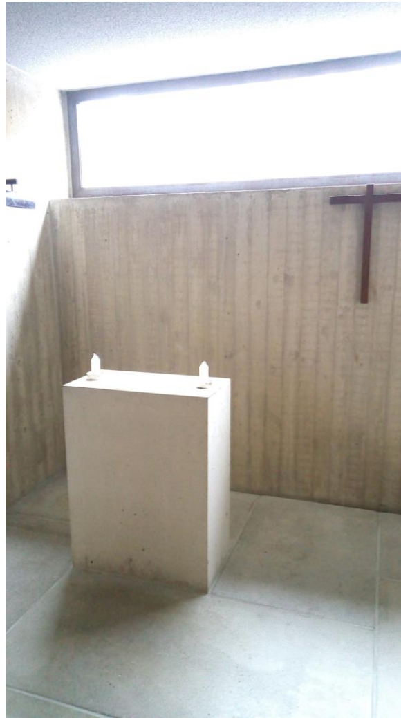
Kuva 32. Uurnanluovutukselle on oma huone, johon valettu betonista urnahylly.
