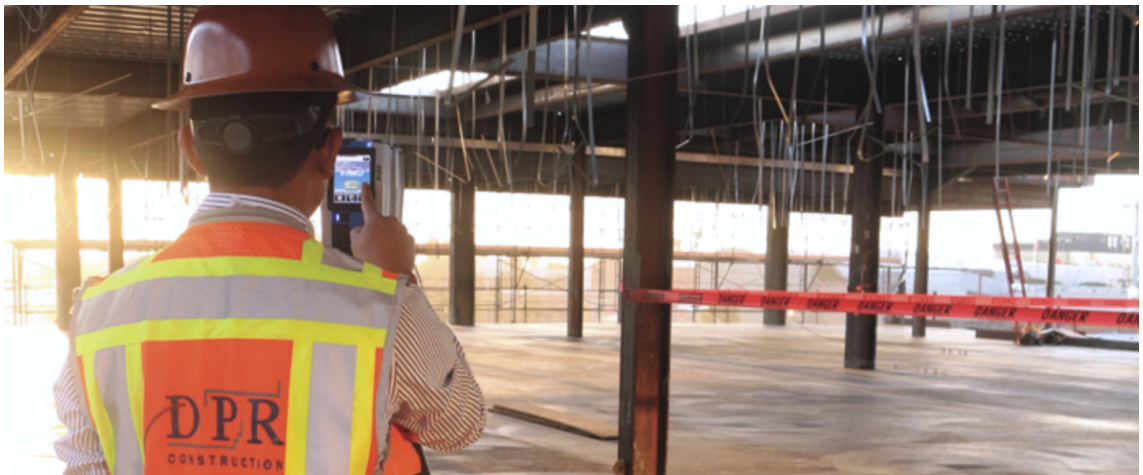
KUVA 36. Lattiavalun laserskannausta (DPR Constructions 2017)
