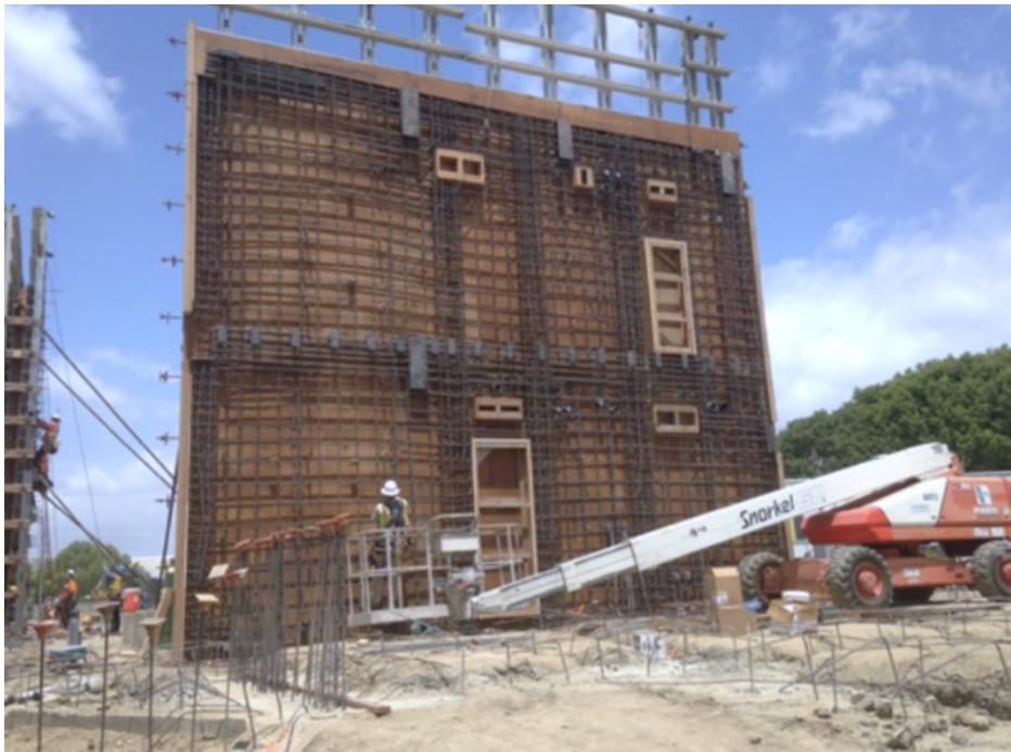
KUVA 30. Esimerkkiseinä ennen betonivalua (Gene Roe 2016)
