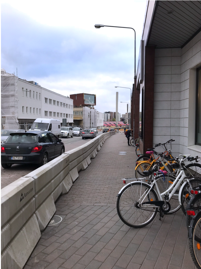
KUVA 16. Näkymä suvantokadun puolelta skannaushetkeltä (Maiju Lahikainen 2017)
