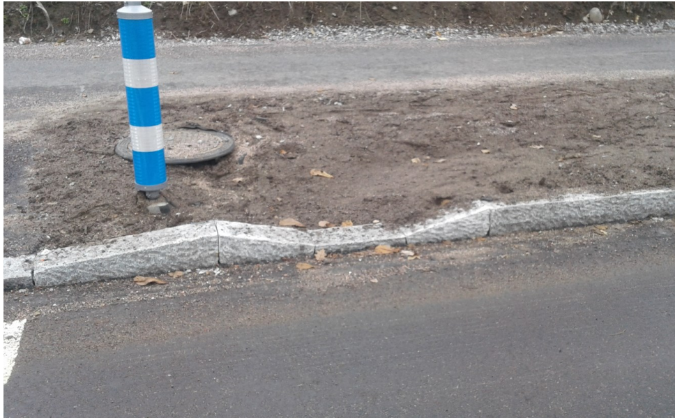
Kuva 39. Kyösti Kallion kadun kahdessa hulevesitaskussa vesi ohjattiin tasukuun madallettu reunakiven kautta. Samaa reittiä se myös poistuu, jos tasku täyttyy esimerkiksi rankkasateella eikä kaikki vesi ehdi imeytyä soudattavien kerrosten läpi salaojaputkistoon. Ajo-radalla ei ole vielä pinta asfalttia, josta johtuen madallettu reunakivi näyttää olevan asfaltin pintaa korkeammalla. (Siilin 2018.)
