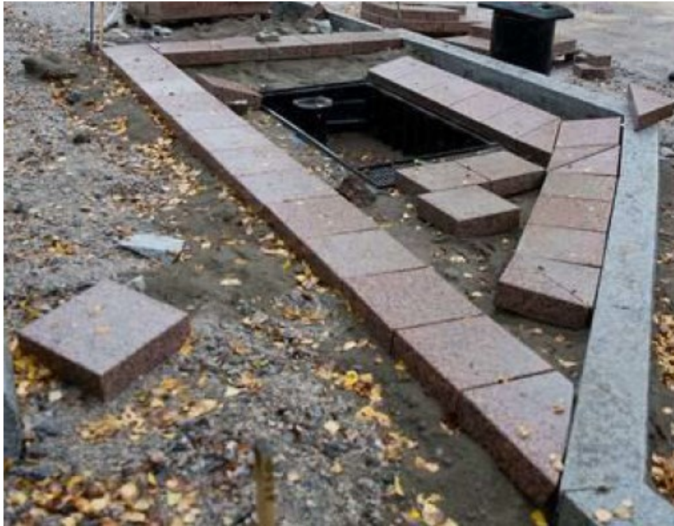
Kuva 42. Rain Gardenia reunustetaan Graniitti laatoilla. Kaikkia suodatuskerroksia ei ole vielä asennettu. Altaan takaosassa näkyy ylivuoto kaivo. (Siilin 2018.)
