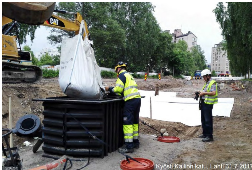
Kuva 41. Rain Gardenin täyttö käynnissä. Tässä lisätään biohiilikerrosta. Kuvassa näkyy myös ankkurilevyt, joilla altaanaan maasta ylös nouseminen estetään. (Kuoppamäki 2017, 23.)
