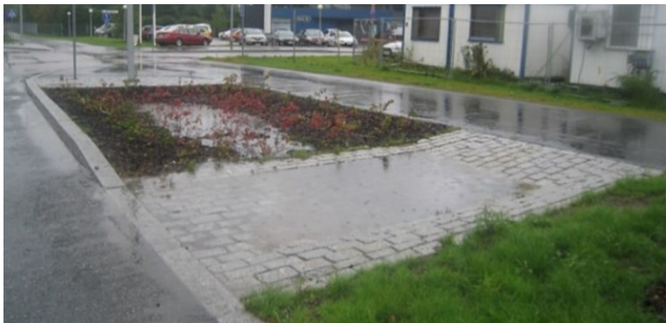
Kuva 7. Meiramintien biosuodatusalue nollareunakivellä (Lehikoinen 2015, 81).
