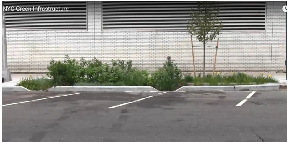
Kuva 16. Joka paikassa ei hulevesitaskun ympärillä ole kaidetta (New York City Water 2013).
