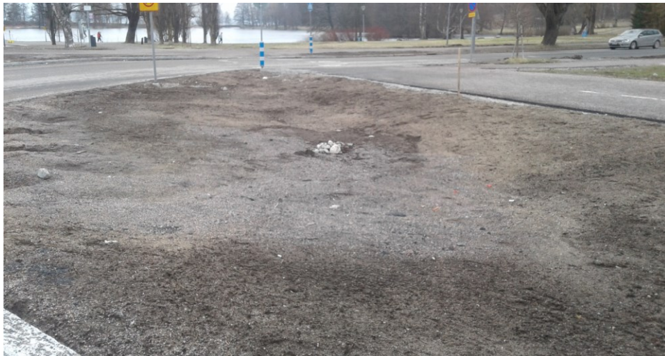
Kuva 29. Kartanonkadun ja Kariniemenkadun kainaloon rakennettu iso hulevesitasku. Kuvan keskellä näkyy kivipesä (Siilin 2018).
