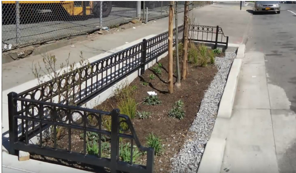
Kuva 14. Hulevesitasku, joka on juuri rakennettu. Kuvassa näkyy hyvin, että taskun ympärillä ei ole tehty muita kadunrakennustöitä, vaan se on asennettu valmiille vanhalle kadulle. (New York City Water 2013.)
