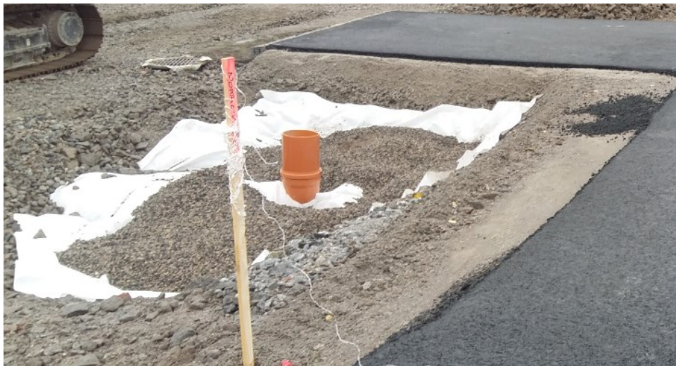
Kuva 26. Kartanonkadun hulevesitasku rakenteilla kitakaivosta tuleva 315 mm yhdysputki, jonka päähän asennetaan kupukansi, näky kuvassa keskellä (Siilin 2017).
