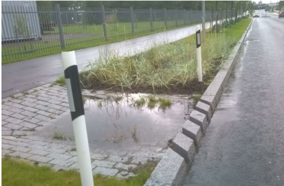
Kuva 8. Meirantien biosuodatusalue aukotetulla reunakivellä (Jormola 2015, 11).
