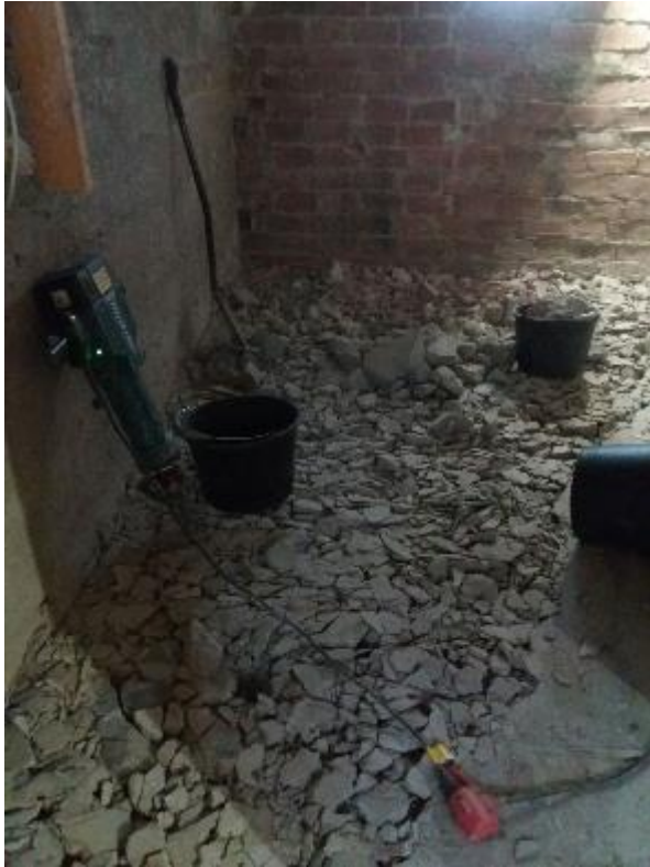
KUVA 21. Kellarin alapohja laatan purkamista maakiilavasasaralla.
