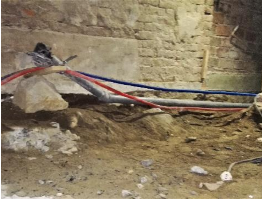
KUVA 23. Pesuhuoneen alta paljastuneita kiviä sekä kalliota.
