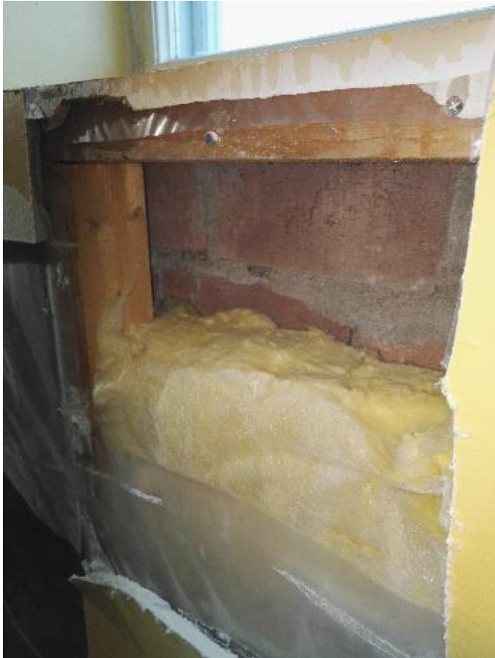
KUVA 15. Vanha kellarin seinän sisäpuoleinen lisäeristysrakenne.
