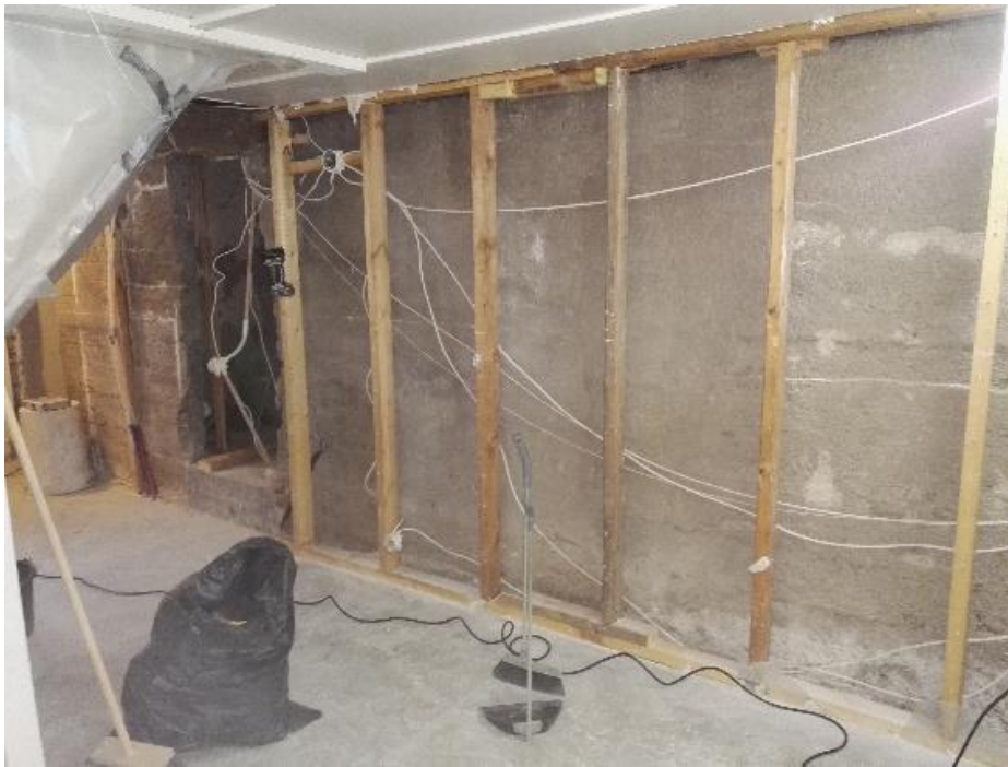
KUVA 17. Kellarin vesijohto- ja sähköasennuksia vanhojen koolausten sisässä.
