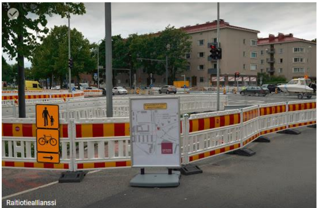
KUVA 12. Jalankulkijoiden ja pyöräliikenteen opasteet, Sammonaukio (TRT, materiaa- lipankki 5.7.2017).
