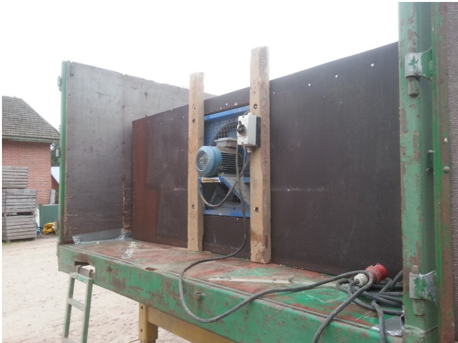
Kuva 35. Puhaltimen asennus ja lämmittimelle jätetty tila. (Kause 2017)
