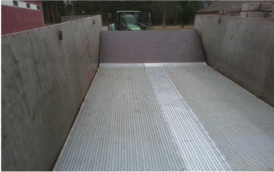
Kuva 34. Puhallinkotelo on asennettuna. (Kause 2017)
