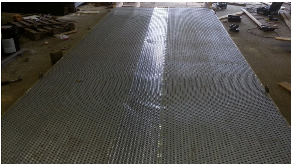
Kuva 22. Suomupelti asennettuna. (Kause 2017)
