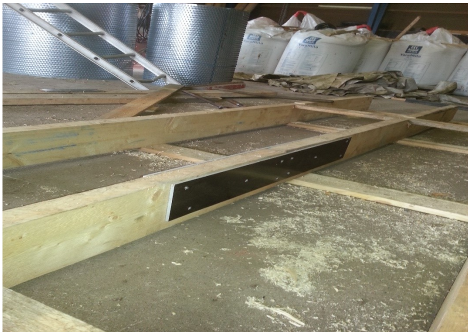
Kuva 18. Runkopalkin jatkos tehtiin filmivanerilla. (Kause 2017)
