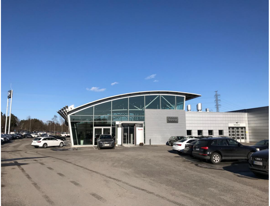
Kuva 1. Turun Audi Centerin pääsisäänkäynti.
