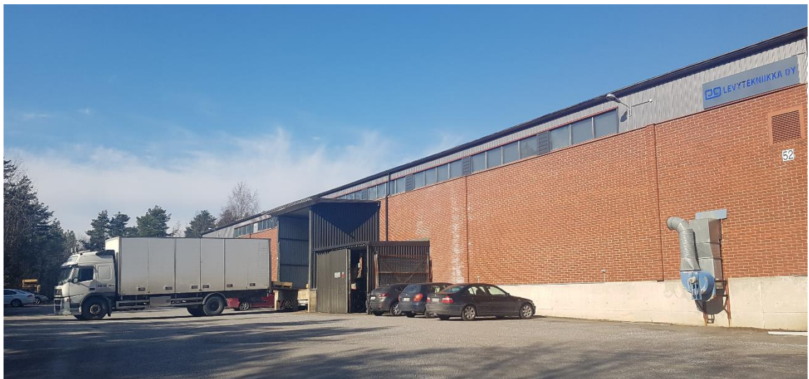
Kuva 1. JL Levytekniikka Oy:n tuotantotilat (JL Levytekniikka Oy 2018).
