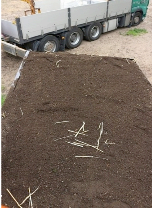
Kuva 9. Kasvualustakerros levitettynä ja muotoiltuna valmiina kasvien istutusta varten (Lemola R. 2017).
