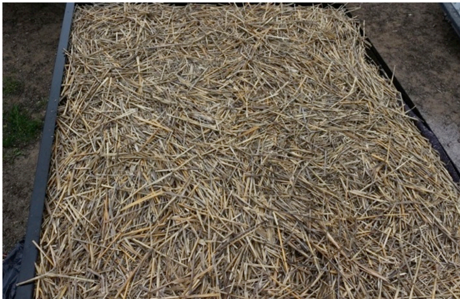
Kuva 8. Viherkaton salaojituskerrokseksi levitetty Vesijärven järvi-ruokoa (Lemola R. 2017).
