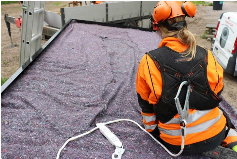
Kuva 7. Turvavarustuksen huomiointi sekä kierrätyskankaasta valmistettu vedenpidätysmatto näkyvät kuvassa (Lemola R. 2017).
