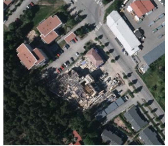
Työmaa käynnissä, viistoilmakuva
