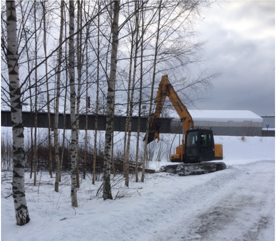
KUVA 4. Giljotiinikouralla varustettu telakaivinkone kaataa koivuja.
