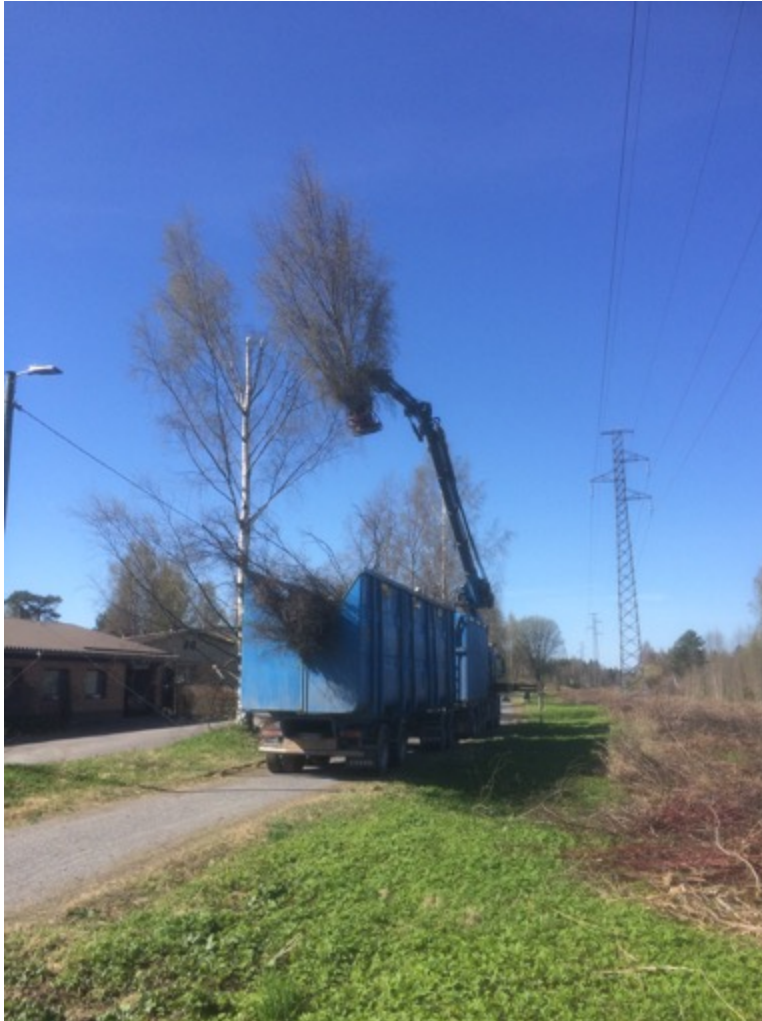
KUVA 5. Giljotiinikouralla varustettu kuorma-auto poistaa katulamppujen sähkölinjan lomassa olevaa koivua.
